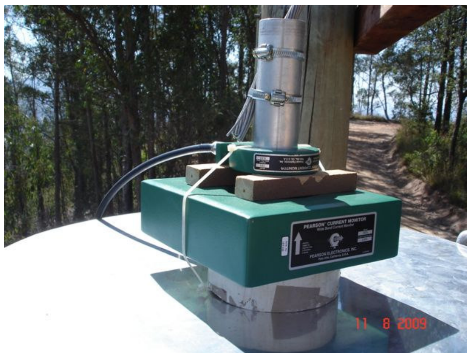
Fig. 3.4 – Bobinas de Pearson instaladas no local.
