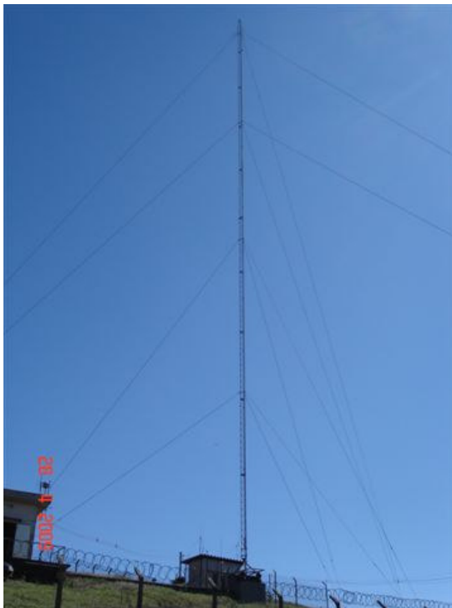
Fig. 3.12 – Visão da torre instrumentada da estação
