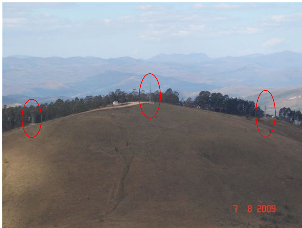
Fig. 3.1 – Local exato da instalação da linha. As elipses destacam as posições das torres.
