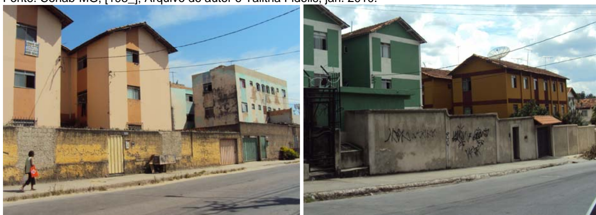
FIGURA 13 – Prédios de apartamentos no Conjunto Cristina - Cristina A e Cristina C
