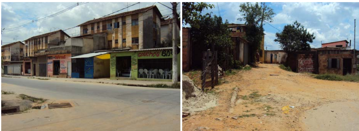
FIGURA 23 – Ocupações irregulares – Avenida Tereza Lourenço Rodrigues, Palmital B e Rua Pontal, Palmital A Fonte: Arquivo do autor, abr. e dez 2010.
