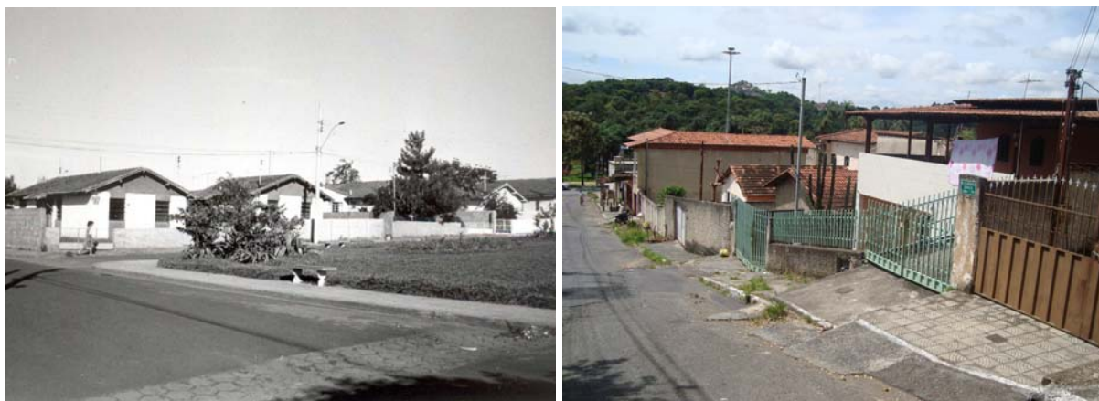
FIGURA 12 – Tipologia de residências unifamiliares presentes no Conjunto Cristina, na década de oitenta e atualmente
