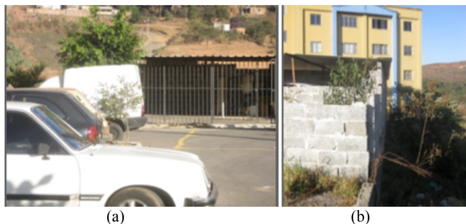
FIGURA 52 – Garagem com fechamento de alvenaria no GFII- Azuis vista de frente e de lado Fonte: Autor, 2010
