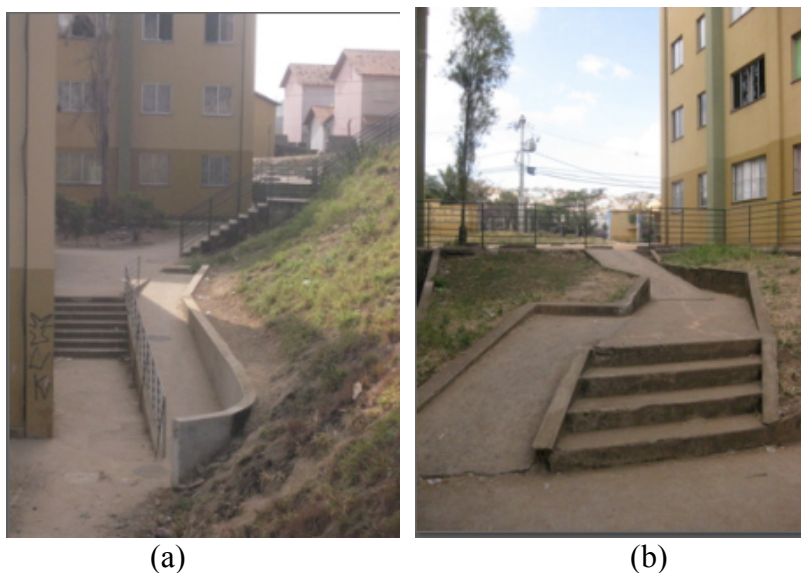
FIGURA 66 – Rampas no GFII - Verdes Fonte: Autor, 2010
