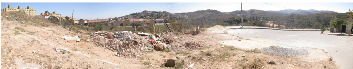
FIGURA 29 – Rotatória do GFI, com acúmulo de lixo e restos de materiais de construção Fonte: Autor, 2010
