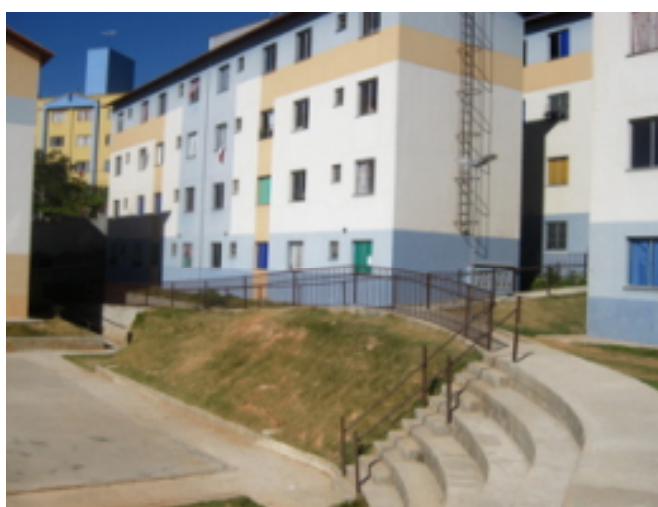
FIGURA 93 – Quadras e arquibancada do GFSPT Fonte: Autor, 2010
