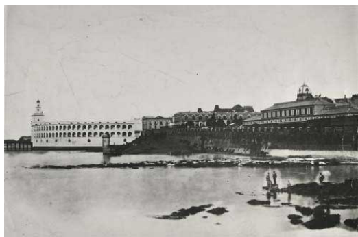
FIGURA 124: A vista de perfil da Aduana, de fundo a casa de governo e a esquerda o prédio do Ferrocarril.
