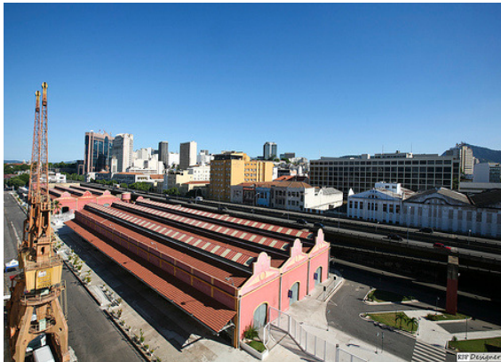
FIGURA 161: Via Perimetral e armazéns do Porto do Rio. Vista por cima.
