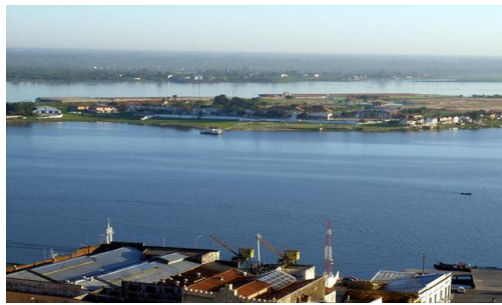
FIGURA 218: Vista do Clube Mbigua banco São Miguel
