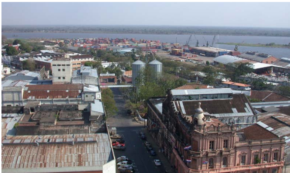
FIGURA 192: Vista aérea parcial da Zona Portuária Fonte: http://www.google.com.br/images
