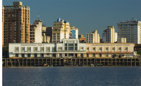
FIGURA 191: Fachada do prédio do Porto sobre o Rio Paraguai. Fonte: http://www.google.com.br/images
