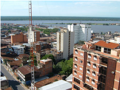
FIGURA 190: Vista aérea parcial da Zona Portuária Fonte: http://www.google.com.br/images
