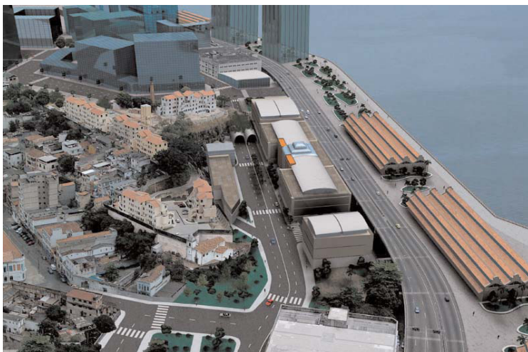
FIGURA 153: Vista geral da área correspondente ao “morro” da Saúde, com as vivendas populares. Ao fundo a proposta da Prefeitura de edifícios para escritórios paralelos aos armazéns do porto Fonte: Roberto Segre.
