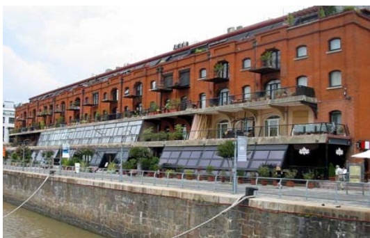
FIGURA 128: Antigos docas em tijolos e estrutura de ferro. Trabalhos de reciclagem. Setor oeste. Fonte: http://www.google.com.br/images
