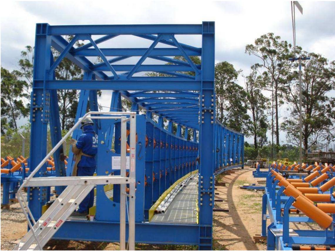
FIGURA 2.9. Estrutura tipo galeria sendo montada. (Fonte: Koch do Brasil Projetos Industriais Ltda)
