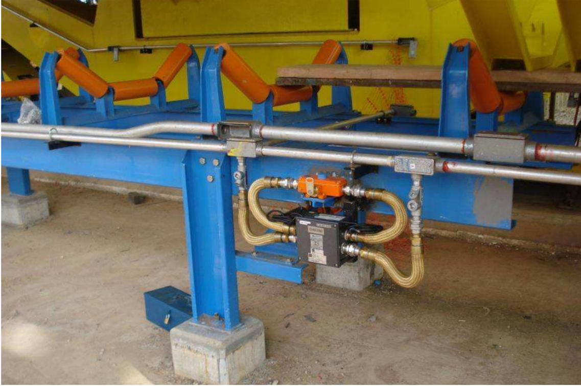
FIGURA 2.11. Chave elétrica e dutos de cabos elétricos. (Imagem cedida pela Koch do Brasil Projetos Industriais Ltda)
