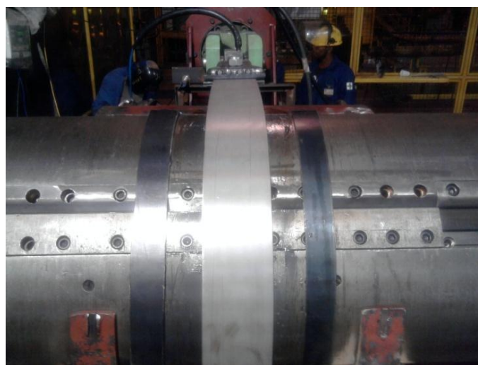
FIGURA 3.17 - Detalhe da tira conformada sobre o segmento.
