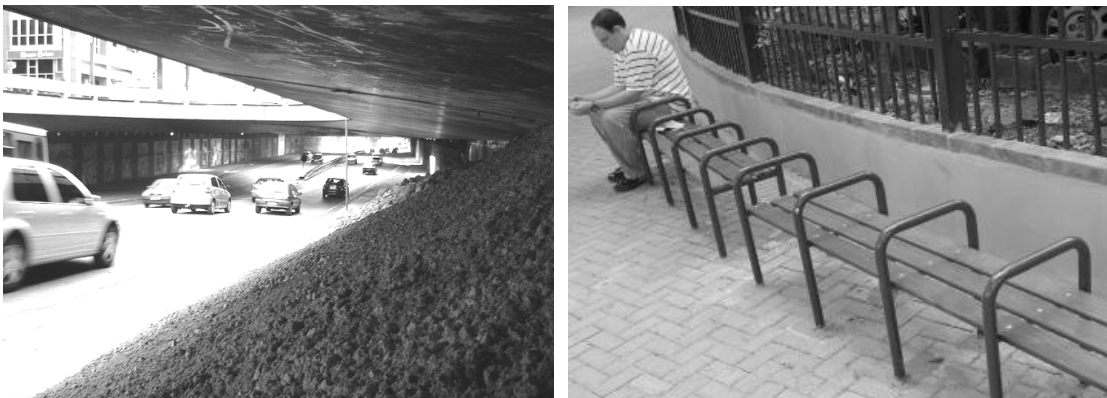
FIGURA 11 – Rampa sob viaduto e banco “antimendigo” em São Paulo
