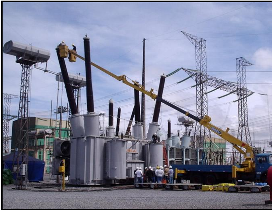
Figura A.2 - Montagem de um Transformador de Potência
