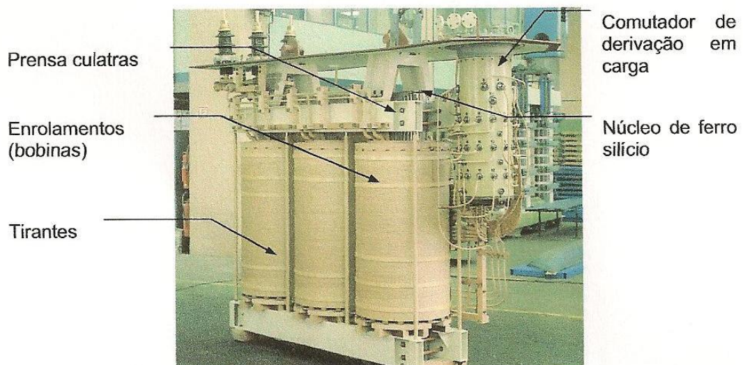
Figura A.3 - Parte Interna de um Transformador de Potência
