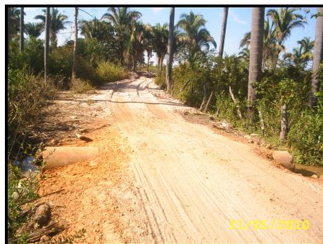
**FIGURA 26** - Travessia no córrego da vereda Seca com manilhas de concreto
