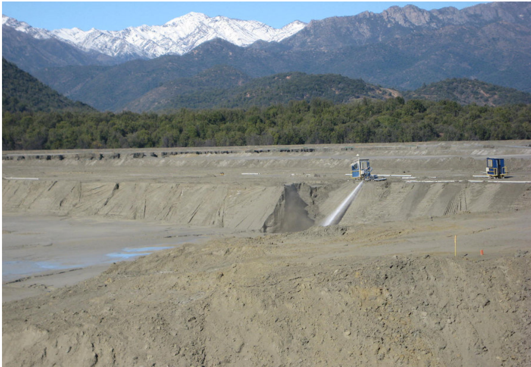
Figura 5.2: Sistema de corte por canhão hidráulico.
