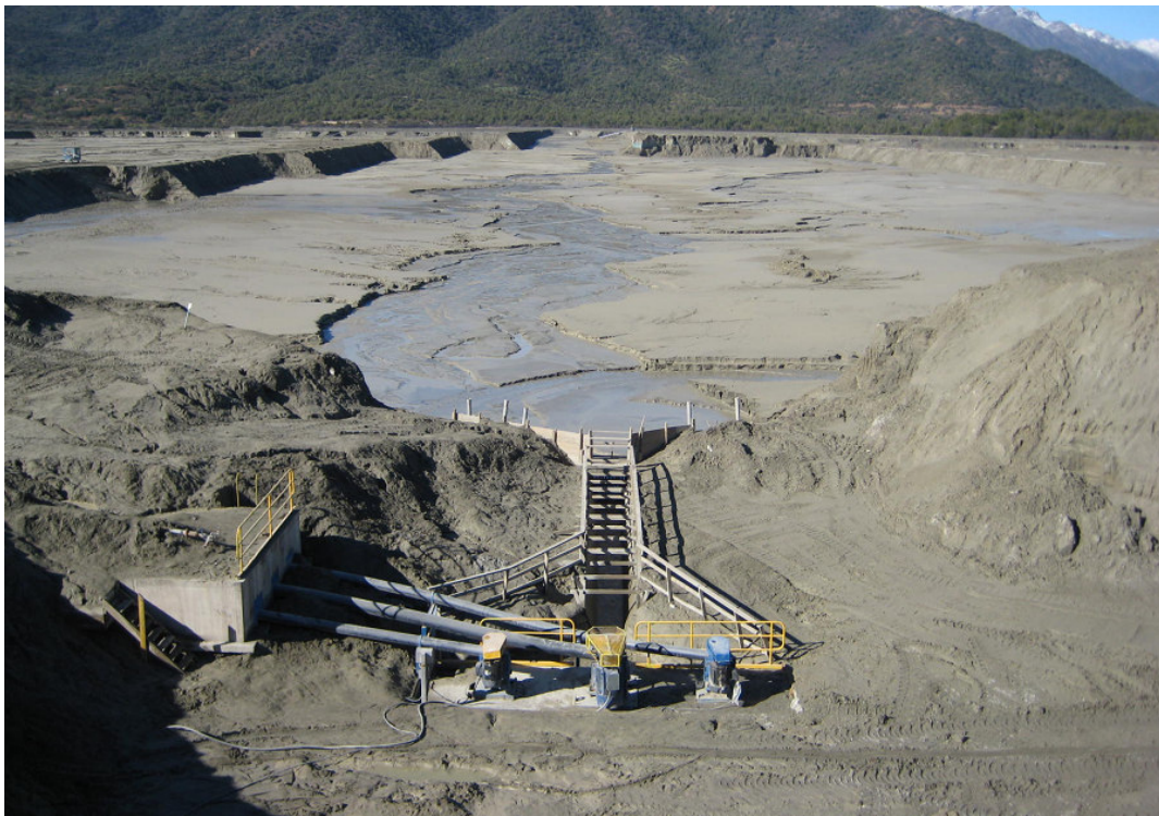
Figura 5.3: Carreamento e bombeamento.
