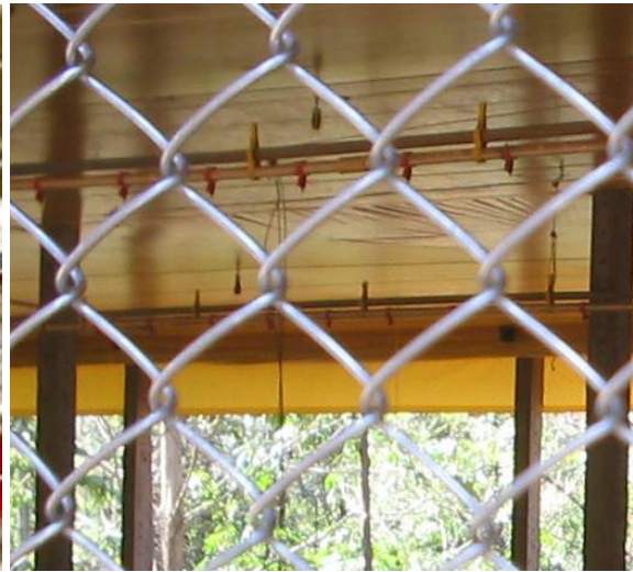
Figura 3: Tela ABNT 10118 (malha simples torção) em uso na avicultura industrial.
