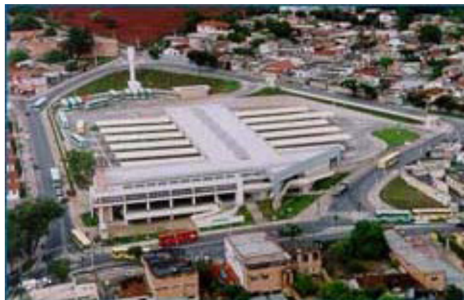
FIGURA 1.7: Vista Aérea da Estação BHBUS Venda Nova. FONTE: GOOGLE EARTH, 2011.
