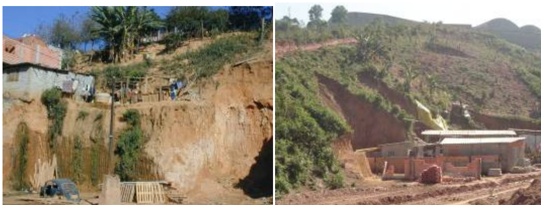
FIGURA 3.17 – Esquema representando a declividade e altura excessivas de cortes (Fonte: IPT, 1991).
