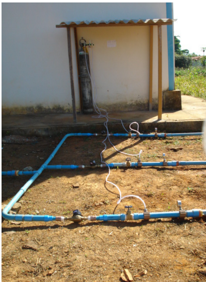
FIGURA 4.8 - Instalação do sistema de injeção de CO 2 nas linhas principais do sistema de irrigação
