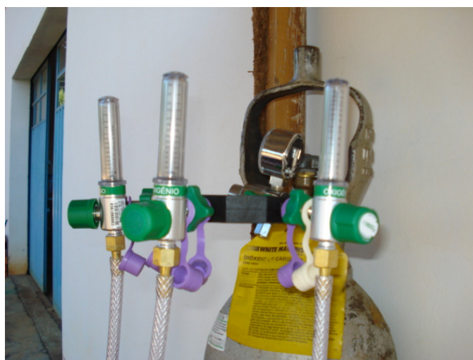
FIGURA 4.7 - Válvula reguladora da vazão de gás com três saídas com fluxímetro, do sistema de distribuição de CO 2 nas linhas de irrigação
