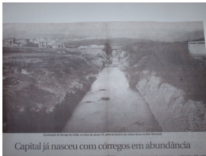
Figura 2 – Canalização do Córrego do Leitão, início do séc. XX, parte da história dos subterrâneos de Belo Horizonte
