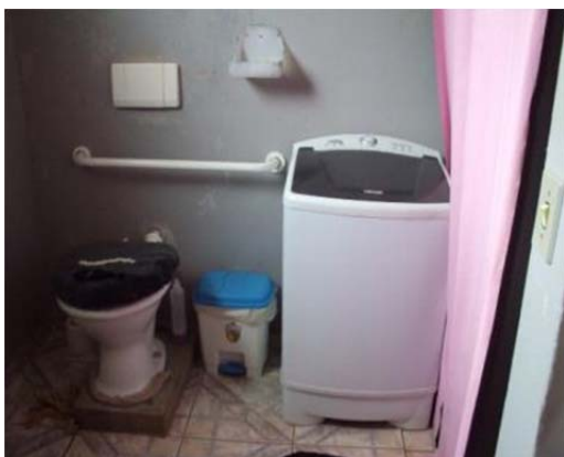
FOTO 22 - Máquina de lavar roupas no banheiro impedindo a circulação e transferência do morador usuário de cadeira de rodas.
