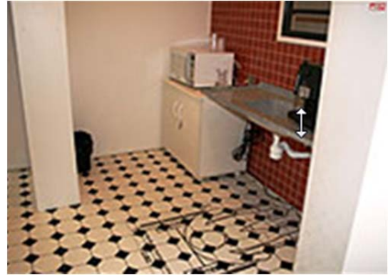
FOTO 2- Casa montada CDHU- Área de serviço, com espaço para circulação baseada nos princípios do desenho universal.
