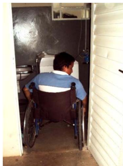
FOTO 23 - Máquina de lavar no banheiro em frente ao lavatório impedindo a sua correta utilização.
