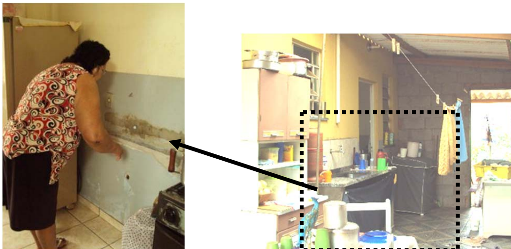
FOTO 24 e 25 - A moradora com problemas de saúde, transferiu a bancada da pia localizada na cozinha projetada (à esquerda) para a área externa (à direita) na altura de 90 cm adequada às pessoas que a podem utilizar fato. Foi feito área de acréscimo com varanda já que o dimensionamento da cozinha não atendia às necessidades da família.
