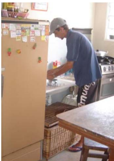
FOTO 11 - Morador com dificuldade de exercer a tarefa de lavar utensílio de cozinha, pela baixa altura da bancada. Além disso, móveis e objetos geram barreiras.
