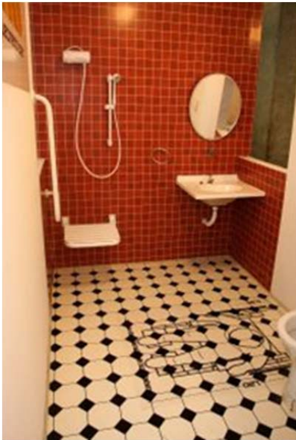
FOTO 3 - Banheiro acessível com possibilidade de receber adaptações como barras e louças.
