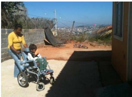
FOTO 19 - Rampa íngreme de acesso à residência executado sem previsão em projeto.
