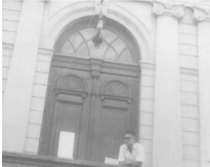
Figura 9 Detalhe da porta, no prédio original, 1954. Fonte: Arquivo Pessoal de E19.
