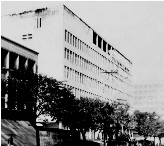
Figura 23 Fachada do Hospital Bias Fortes, s/d. Fonte: Acervo AC/ HC/ UFMG
