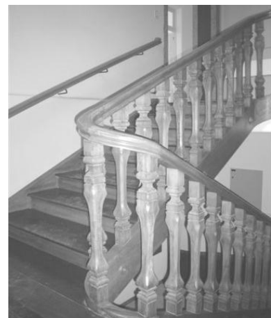
Figura 22 Vista de detalhe arquitetônico do Hospital Borges da Costa, 2003 Fonte: Acervo AC/HC/UFMG
