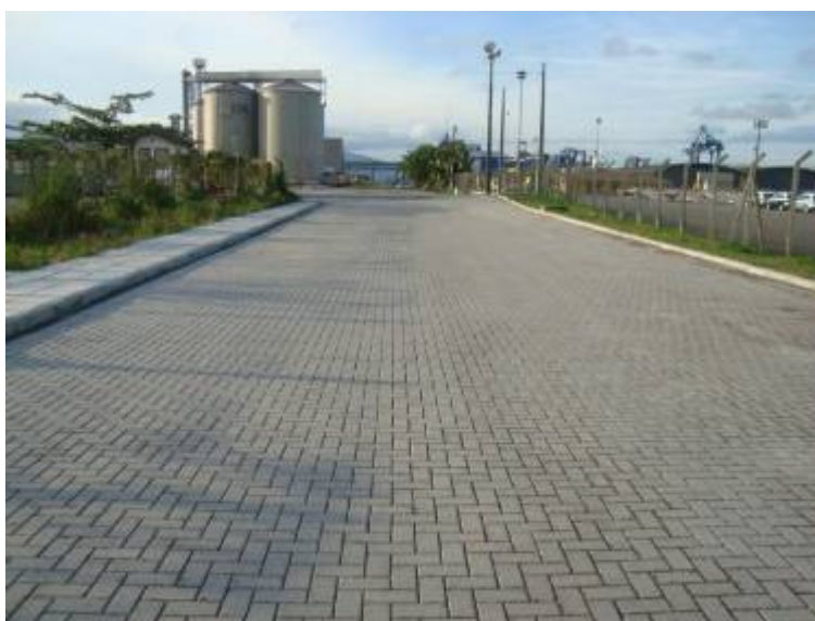
Figura 3-55 Pavimentação com blocos retangulares de piso
