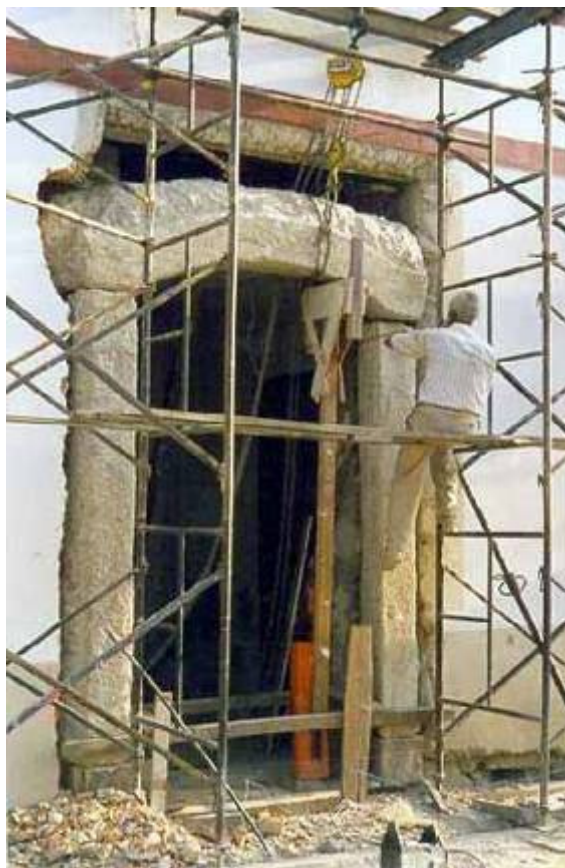
Figura 3-27 Restauração de umbrais e verga em cantaria (Pereira, 2007).
