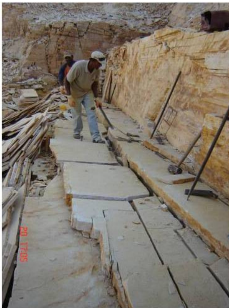
Figura 3-34 Remoção das placas em lavra de mineradora na serra da Canastra (Valadão et al, 2010).
