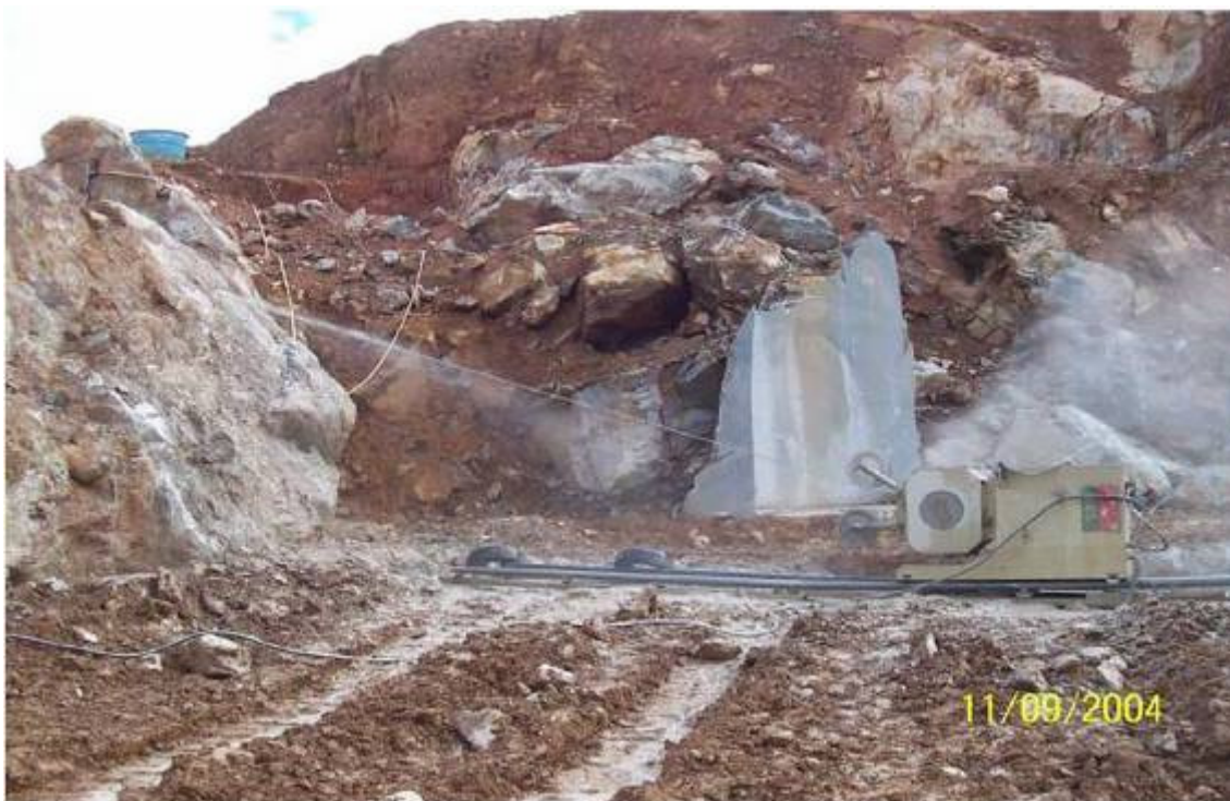
Figura 3-13 Corte vertical com fio diamantado em maciço de esteatito (Almeida, 2006).
