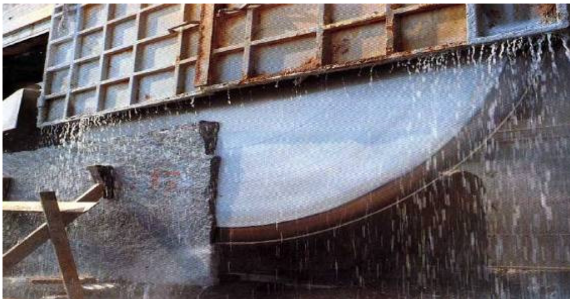
Figura 3-16 Talha-bloco monodisco com disco diamantado de grande dimensão (Coimbra Filho, 2006).
