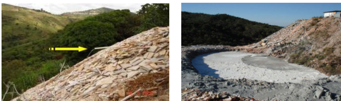
Figura 3-20 Disposição desordenada (esquerda) e tanque de decantação de rejeitos finos em polpa provenientes de polimento de quartzito (direita) em Ouro Preto (Pires, 2007).
