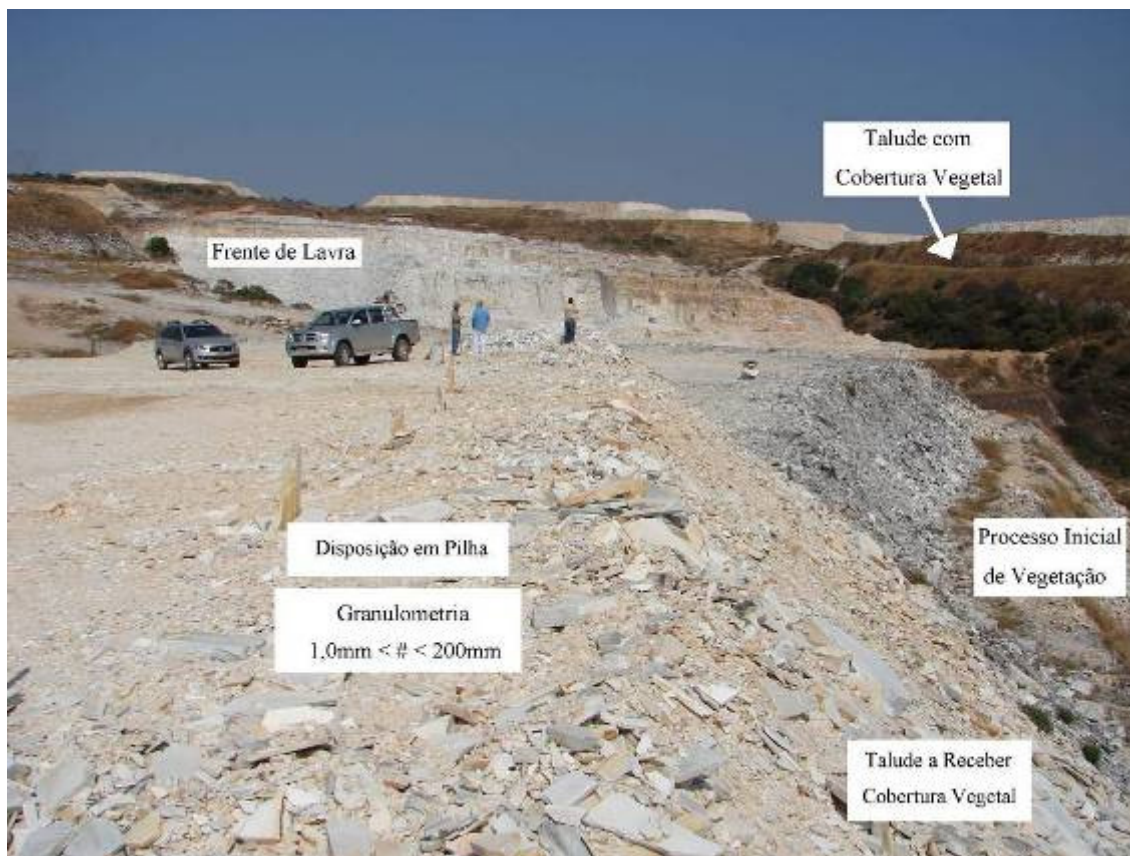
Figura 3-19 Taludes de depósito de rejeitos de quartzito – Alpinópolis.
