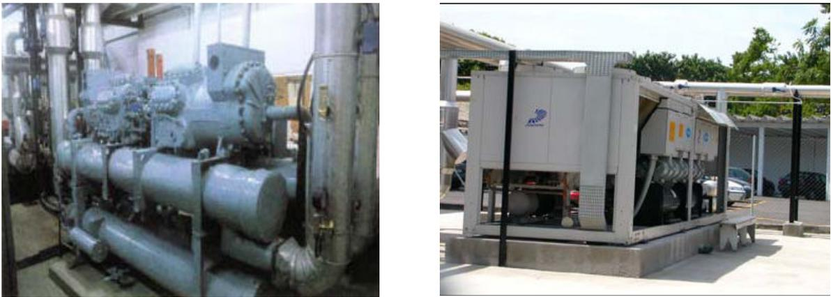
**Figura 19:** À esquerda Chiller condensação a água. À dir. Chiller com condensação a ar
