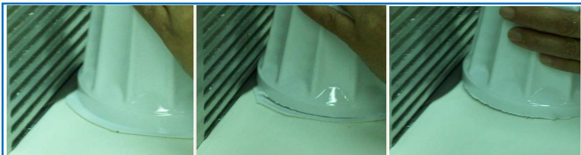
Figura 63 – Processo de corte do excesso de material e ajuste da altura da peça.
