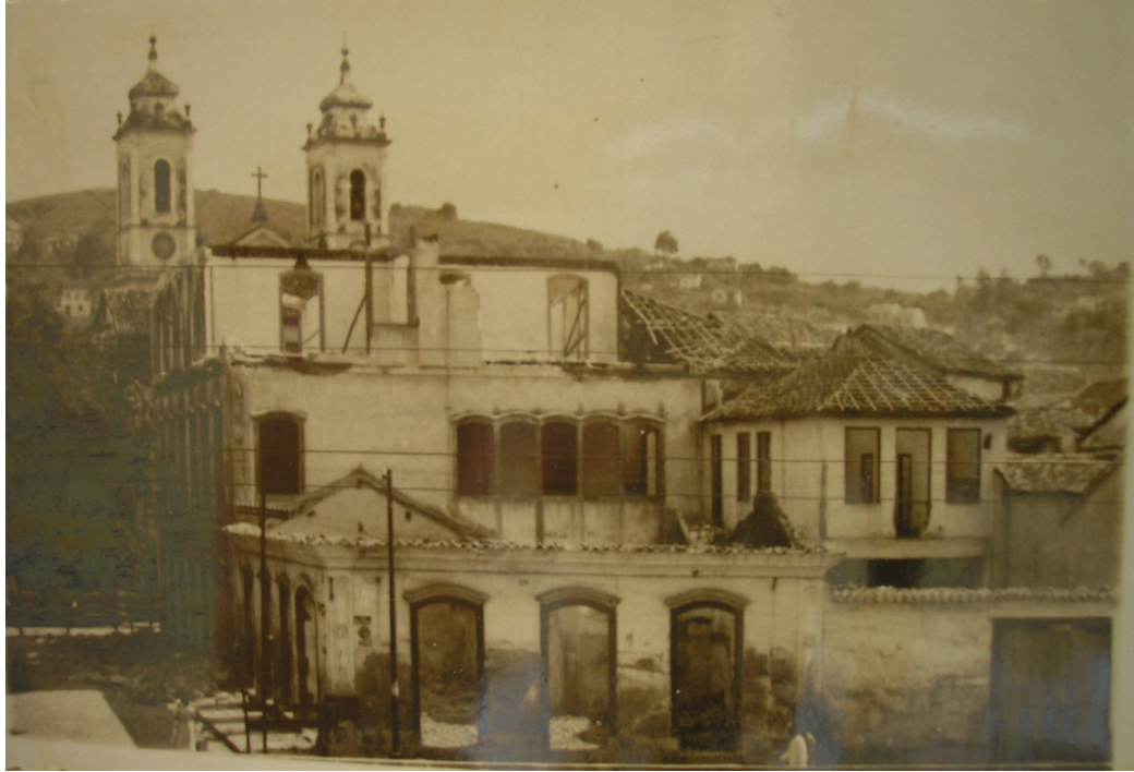
Figura 9: Demolição do Sobrado à Praça Severiano Resende (a) – (S/d) – Arquivo do Museu Regional de São João del-Rei
