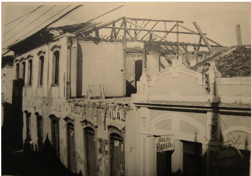
Figura 15: Lateral da fachada do casarão à rua Artur Bernardes e Marechal Deodoro (b) – (S/d) – Arquivo do Museu Regional de São João del-Rei
