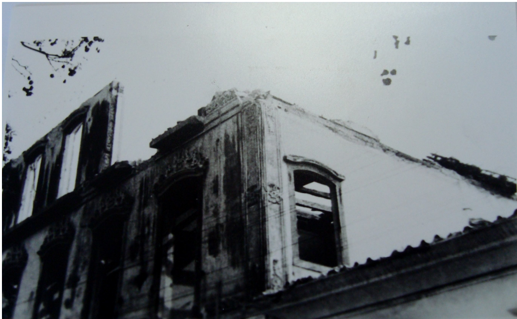
Figura 10: Demolição do Sobrado à Praça Severiano Resende (b) – (S/d) – Arquivo do Museu Regional de São João del-Rei
