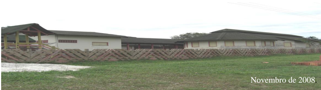
Foto 6: Escola vista de lado: Em alvenaria, a cozinha e em madeira as salas administrativas.
