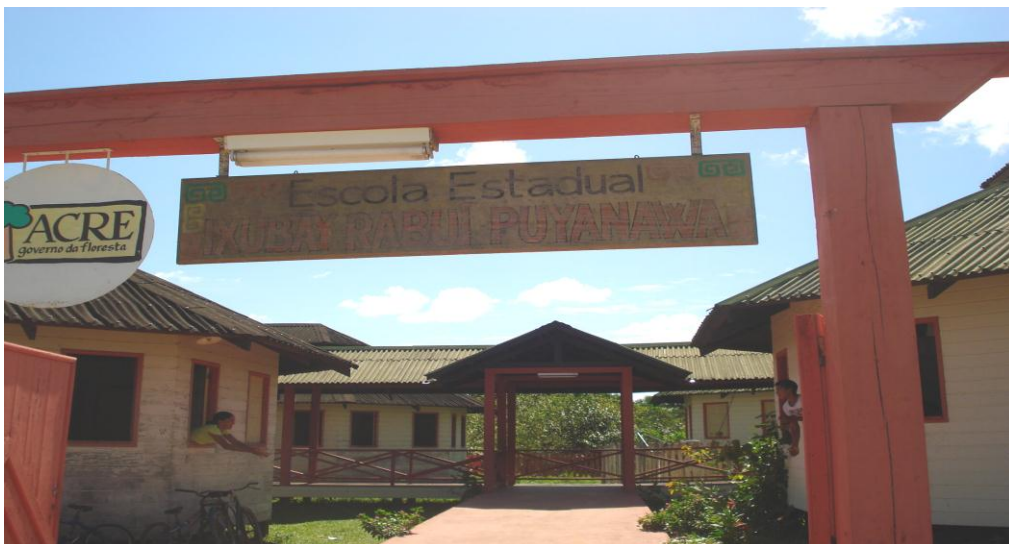
Foto 5: Fachada da escola.
