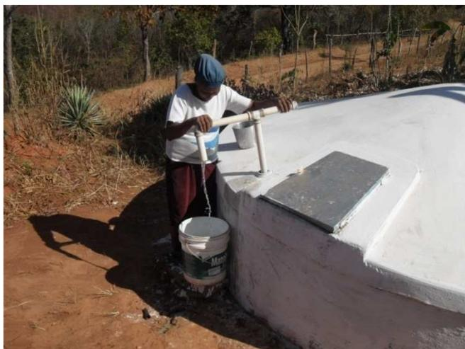
**Figura 5.14** – Beneficiária utilizando a bomba manual para retirada da água da cisterna
