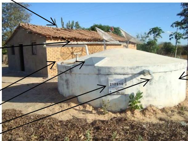
A cisterna de placa tem capacidade para armazenar 16.000L de água.
