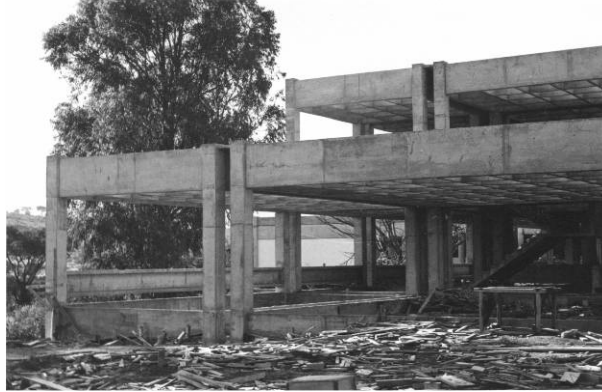
Figura 146 - Construção da Escola de Educação Física
