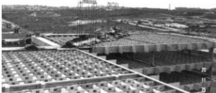
Figura 132 - Instituto de Ciências Biológicas – Construção da estrutura – montagem das vigas (1975)
