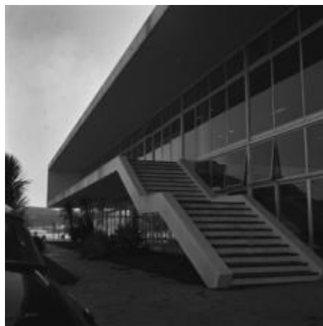
Figura 83 - Escadaria externa da Reitoria. Leveza e plasticidade no uso do concreto armado.
