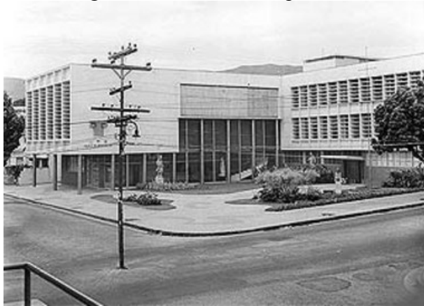
Figura 8 - Escola de Arquitetura
