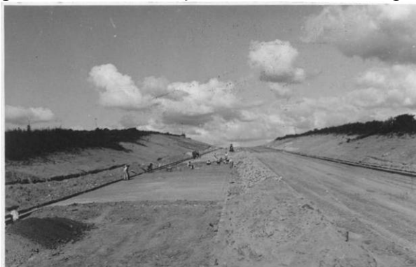
Figura 21 - Pavimentação da Avenida da Pampulha
