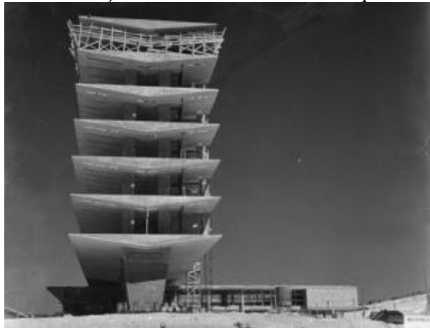
Figura 82 - Construção da Reitoria. Vista do esqueleto estrutural
