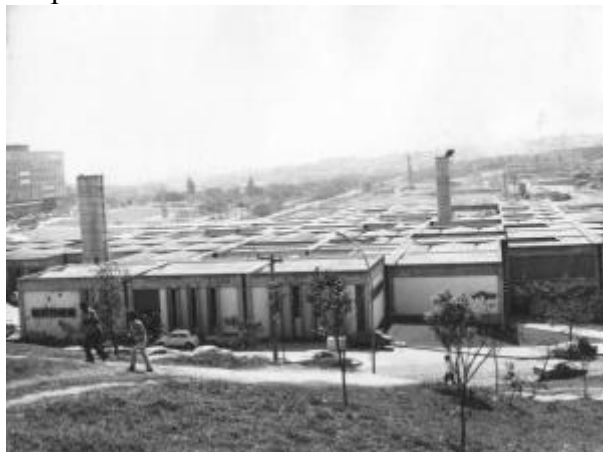
Figura 269 - Departamento de Física - Vista da fachada sudoeste (1980)
