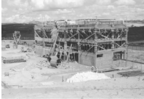
Figura 100 - Construção do Bloco do Reator TRIGA
