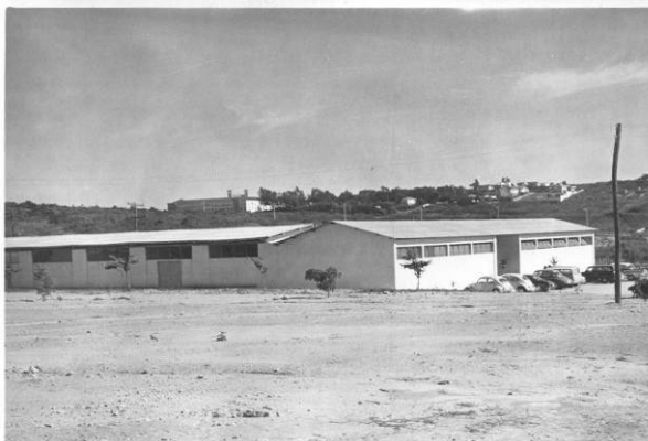
Figura 75 - Ampliação do Posto Policial
