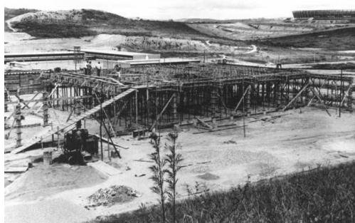
Figura 105 - Construção do Restaurante Universitário
