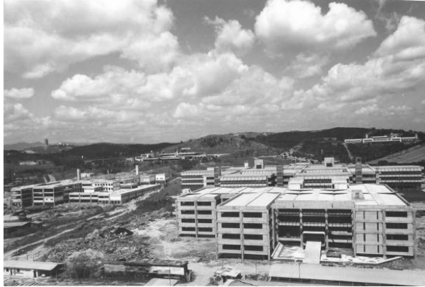
Figuras 261 - Vista da Biblioteca Central em fase de construção
