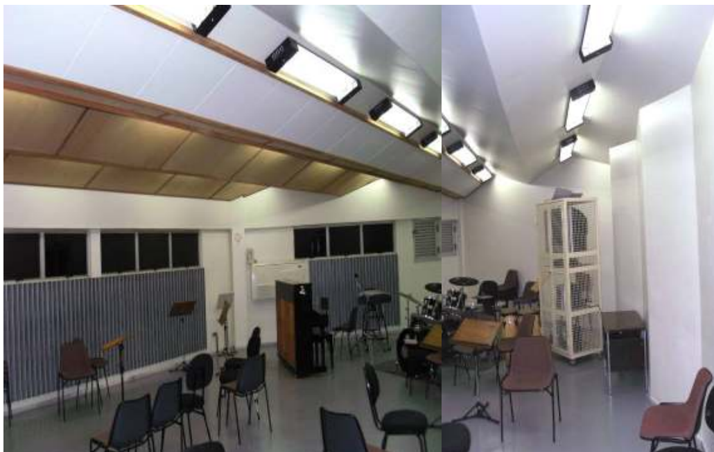
FOTO 11: Sala 3003. Paredes irregulares em gesso e difusores de ardósia próximos às janelas
