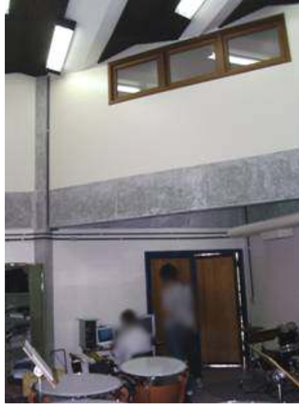
FOTO 9 : Sala de percussão com janela de vidros duplos que chega ao segundo andar do prédio.
