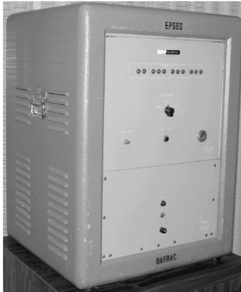
Figura 2.1: ADC “DATRAC” valvulado de 11 *bits*, 50 kSPS.
