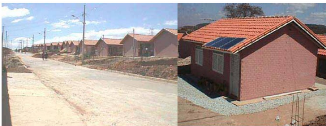
Figura 2.6: Aplicação de coletores para uso residencial em casas populares – Contagem MG Fonte: GreenSolar, PUC-MG
