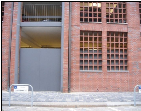
Figura 3.25 (c) comportas metálicas instaladas nas aberturas de vãos e (d) comportas metálicas instaladas adjacentes às esquadrias de janelas de edificações, todas no pavimento térreo. Hafencity , na cidade de Hamburgo, Alemanha (Fotografia: Cristiane Parisi Jonov, 2011)
