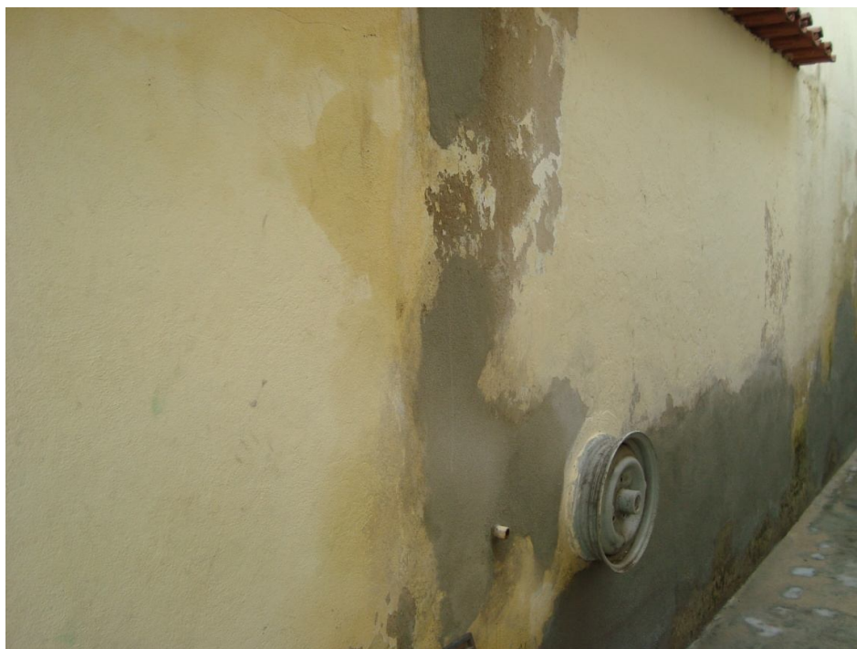
Fotografia 26 – Reconstituição do revestimento argamassado das paredes
