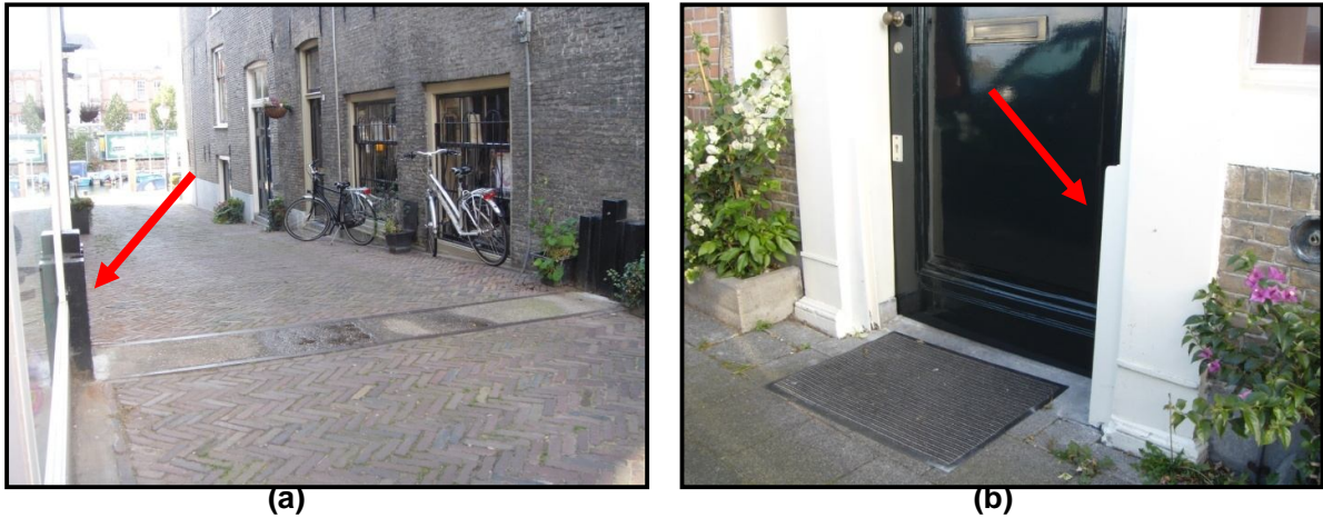
Figura 3.19 Comportas de madeira instaladas (a) em via de acesso de pedestres e bicicletas e (b) em porta de entrada de residência. Medidas de proteção secas provisórias implantadas na cidade de Dordrecht, Holanda (Fotografia: Cristiane Parisi Jonov, 2011)
