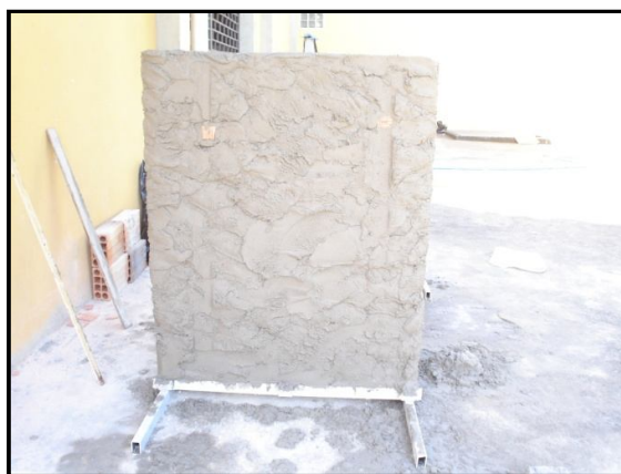
Figura 3.34 Vista de reboco em execução
