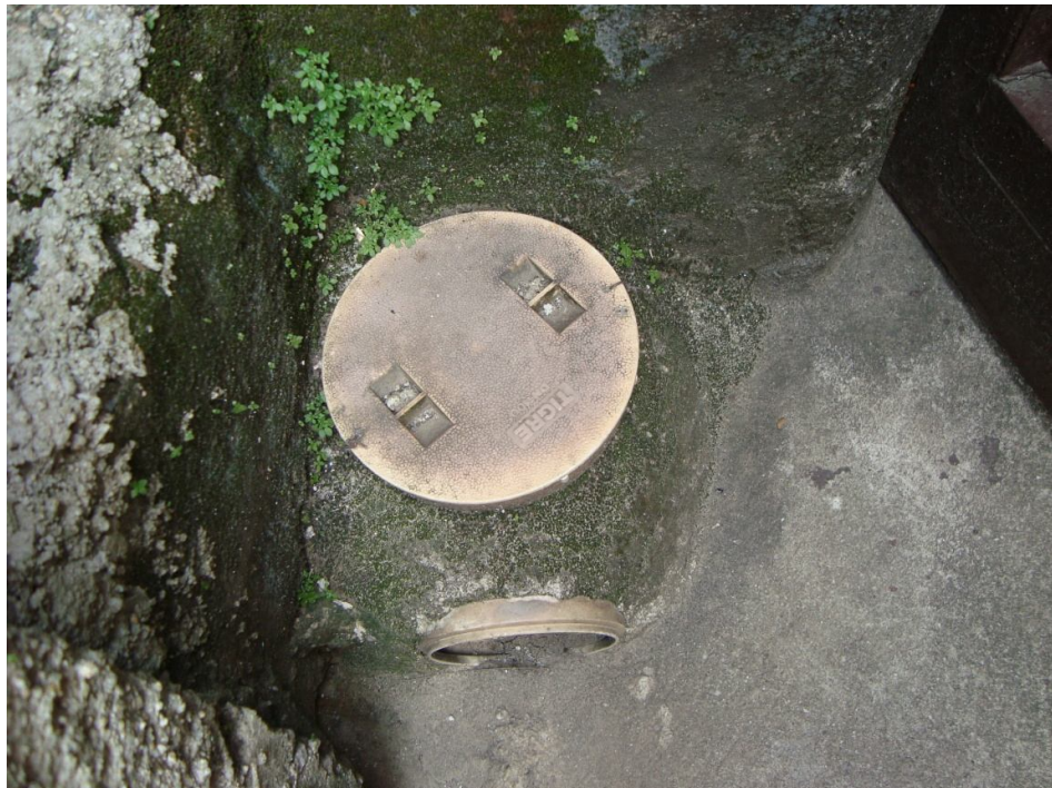
Fotografia 57 – Instalação de válvula de retenção
