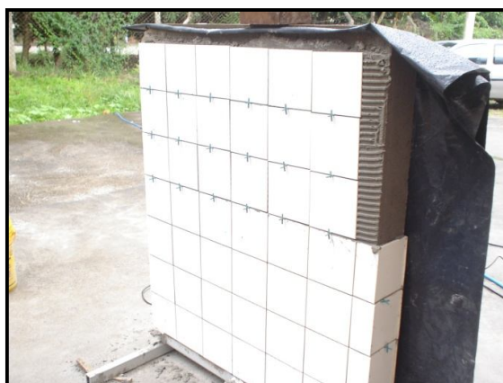
Figura 3.35 Vista de painel em fase de assentamento de azulejos
