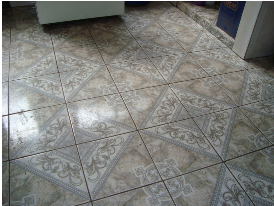
Fotografia 53 – Assentamento de piso cerâmico na cozinha
