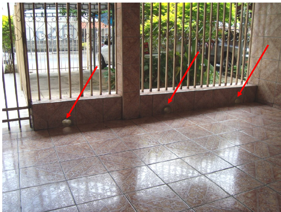
Fotografia 19 – Hall de entrada do bloco B 28 – Colocação de saídas para escoamento das águas de inundação
