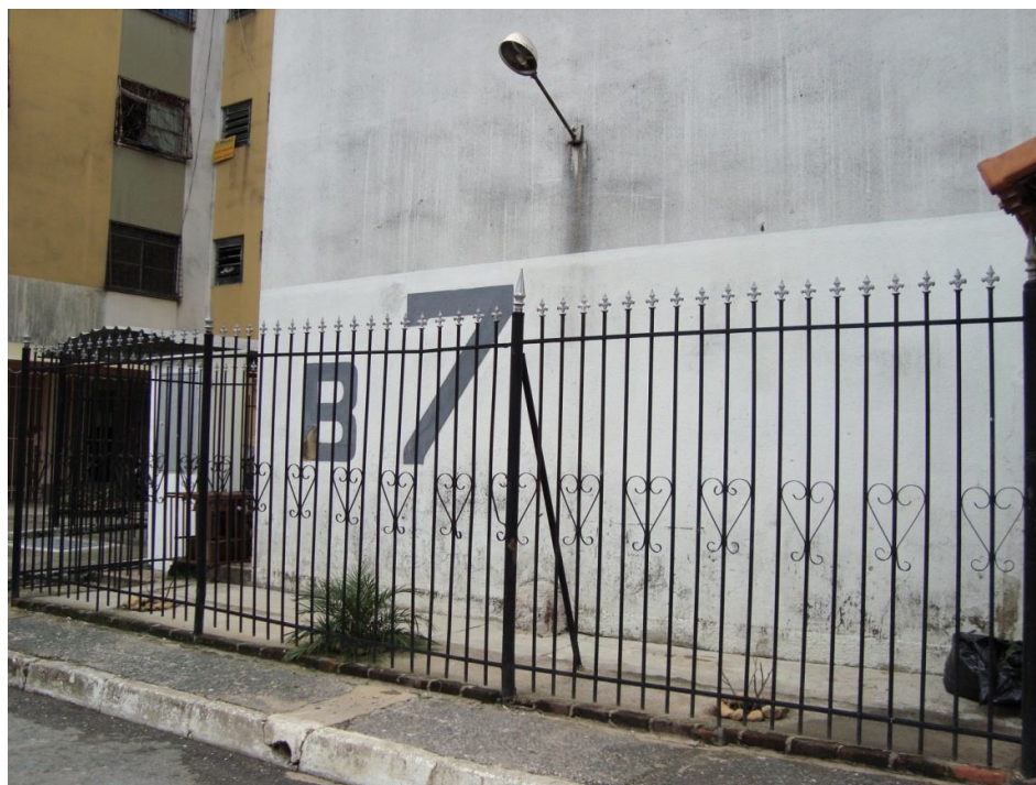
Fotografia 1 – Fachada do Bloco B 7 do Conjunto João Paulo II
