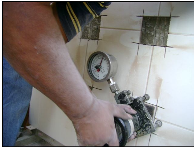
Figura 3.37 Vista de um painel com revestimento cerâmico – arrancamento dos corpos de prova
