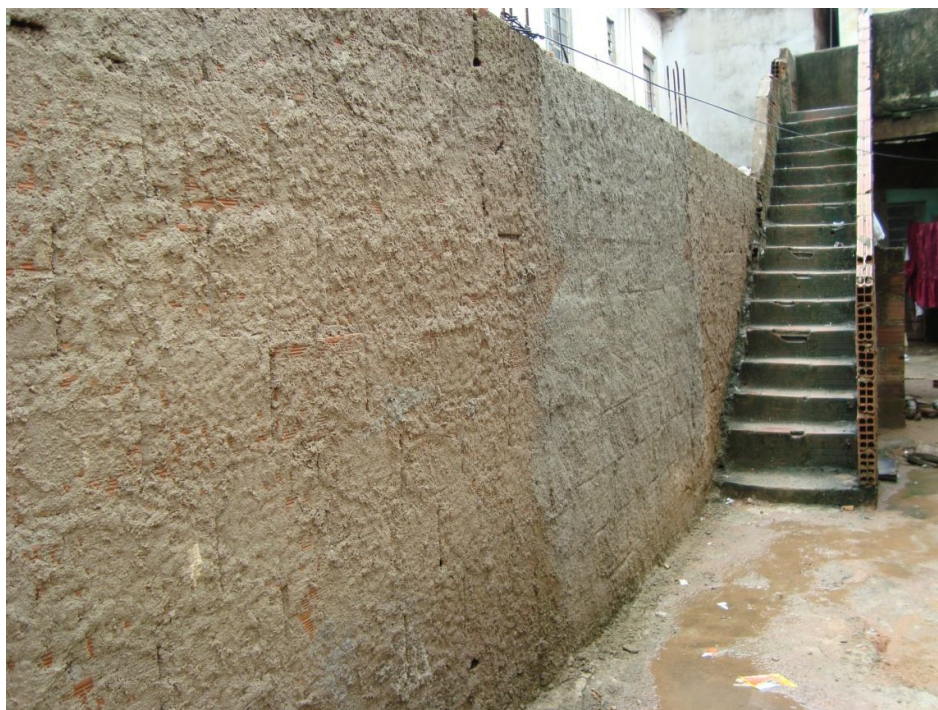
Fotografia 32 – Execução de novo muro
