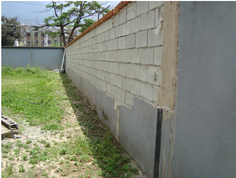
Fotografia 11 – Muro de divisa do Residencial reconstruído após queda
