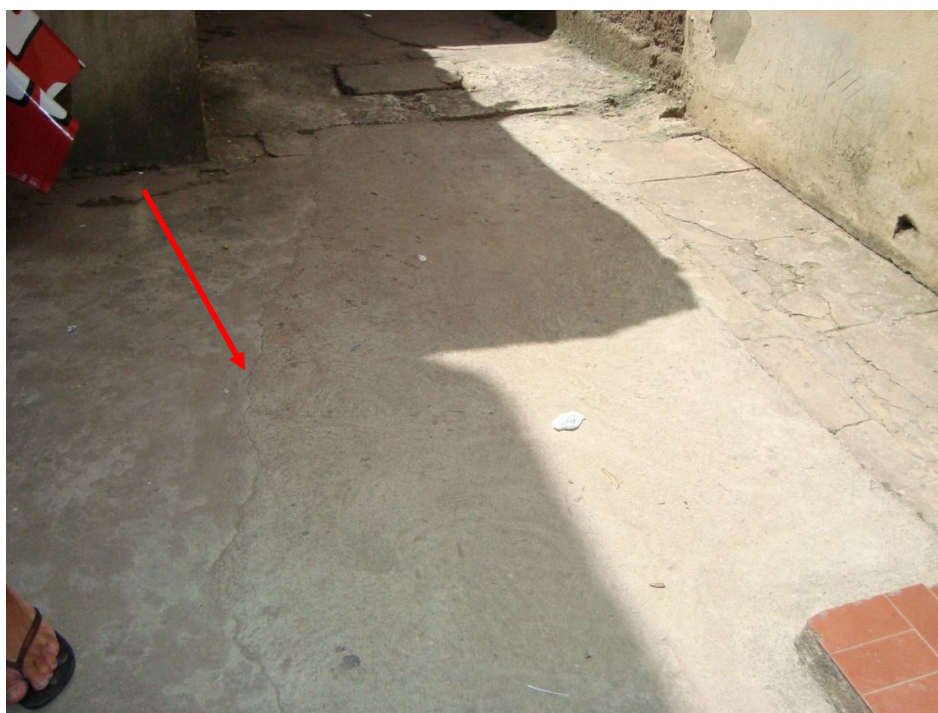
Fotografia 55 – Reconstituição do piso cimentado de área externa
