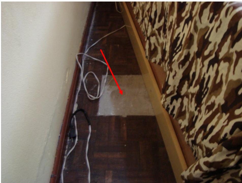
Fotografia 6 – Preenchimentos no piso com argamassa
