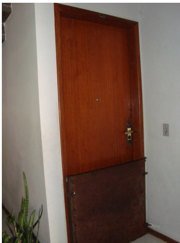
Fotografia 8 – Porta de entrada do apartamento 103 com comporta metálica
