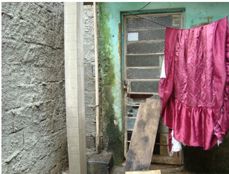
Fotografia 35 – Edícula ao fundo fechada
