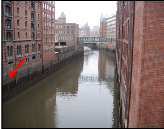
Figura 3.22 Edificações construídas em elevação sobre muros, ao fundo passarela elevada para acesso à edificação durante evento de inundação. Hafencity , na cidade de Hamburgo, Alemanha (Fotografia: Cristiane Parisi Jonov, 2011)
