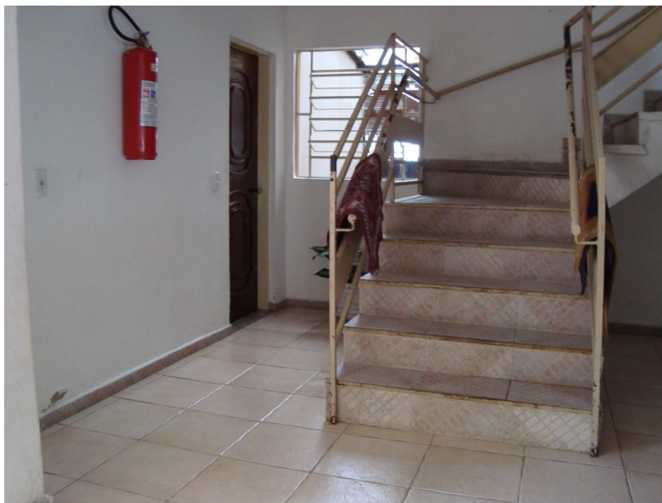
Fotografia 2 – Hall de entrada dos apartamentos térreos e escada de acesso ao pavimento superior do B7
