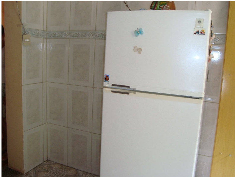
Fotografia 54 – Assentamento de cerâmica de parede na cozinha
