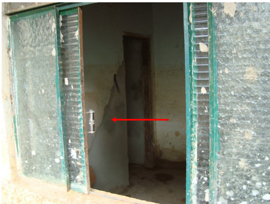
Fotografia 34 – Reconstituição do revestimento argamassado das paredes
