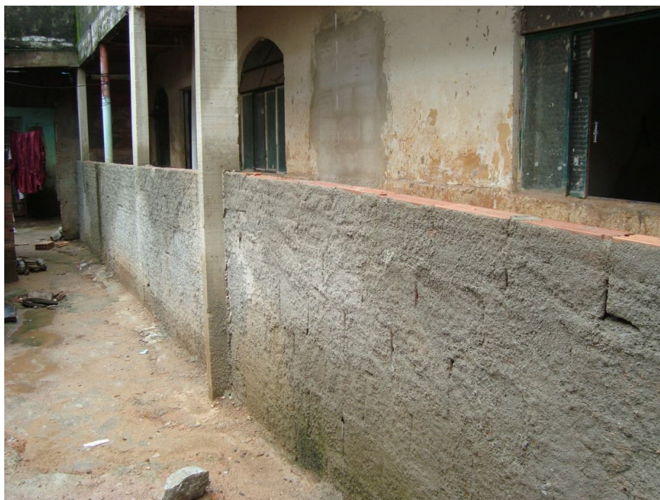
Fotografia 33 – Execução de pilares de concreto e alvenarias
