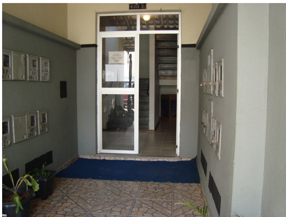
Fotografia 7 – Hall de entrada do Bloco B 5 do Residencial Itália
