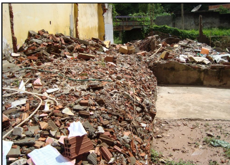
Figura 5.11 Edificação demolida – Casa 19 – 3
