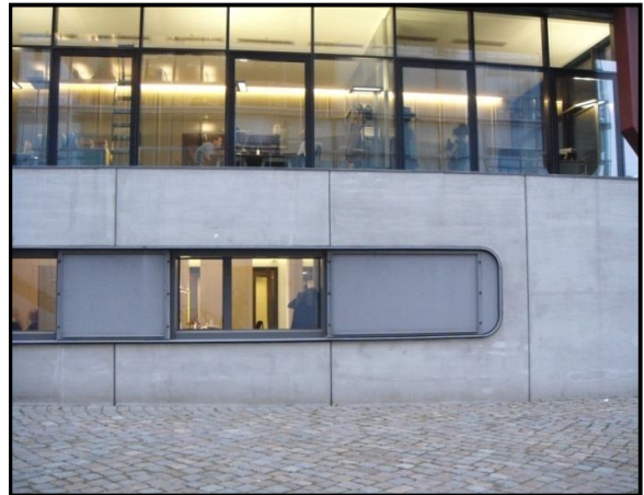
Figura 3.25 (c) comportas metálicas instaladas nas aberturas de vãos e (d) comportas metálicas instaladas adjacentes às esquadrias de janelas de edificações, todas no pavimento térreo. Hafencity , na cidade de Hamburgo, Alemanha (Fotografia: Cristiane Parisi Jonov, 2011)
