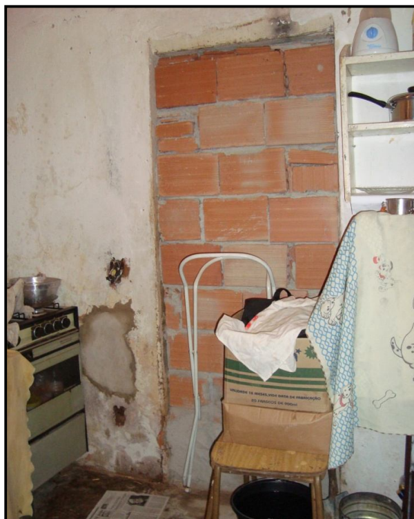
Figura 5.9 Execução de alvenaria para fechamento Figura 5.10 Indicação da altura atingida pelas águas da inundação – Casa 19 – 2
