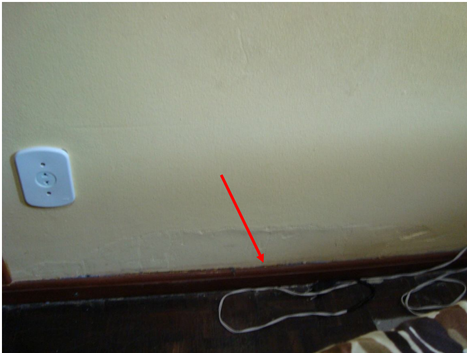
Fotografia 5 – Recolocação de rodapé
