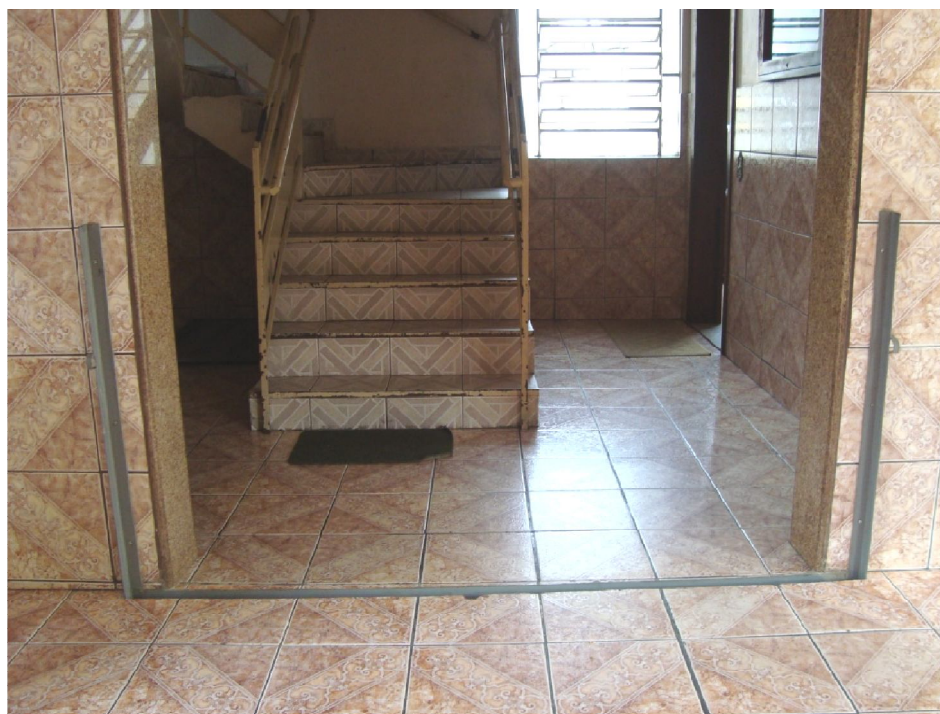
Fotografia 20 – Hall de entrada dos apartamentos térreos com comporta metálica e escada de acesso ao pavimento superior do B 28
