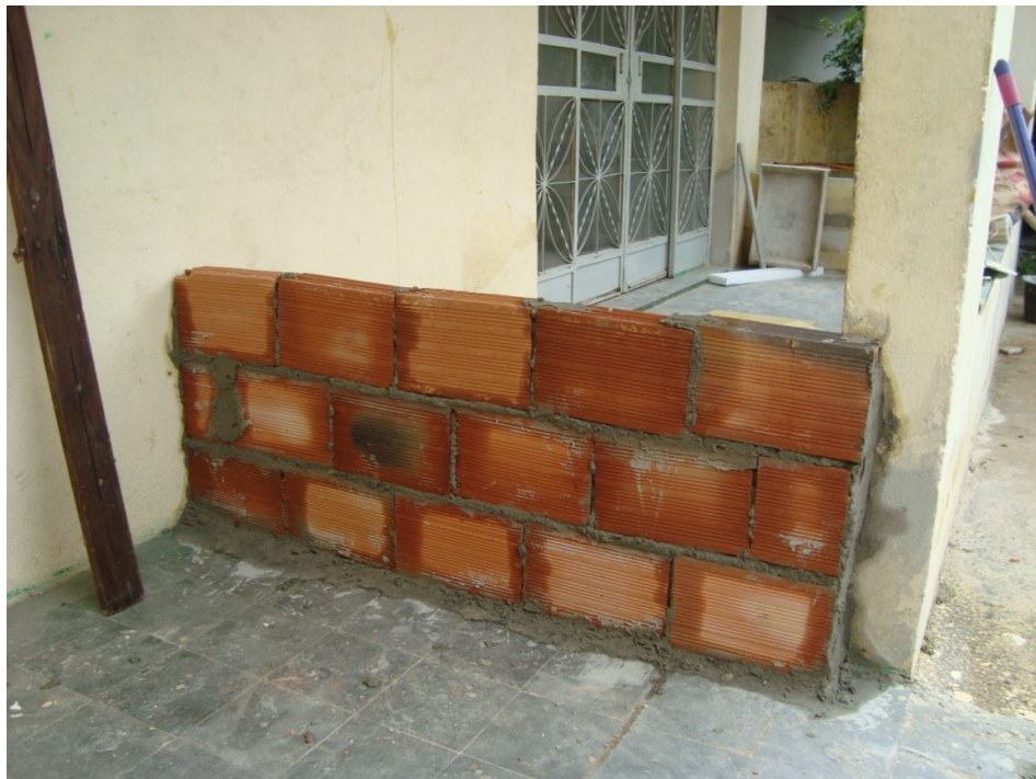
Fotografia 29 – Execução de barreiras de proteção
