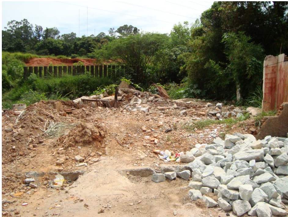
Fotografia 61 – Demolição da casa
