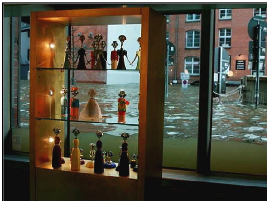
Figura 3.26 Loja durante evento de inundação: esquadrias de janelas e vidros resilientes e resistentes à água. Hafencity , na cidade de Hamburgo, Alemanha (Fotografia: Chris Zevenbergen, 2010)
