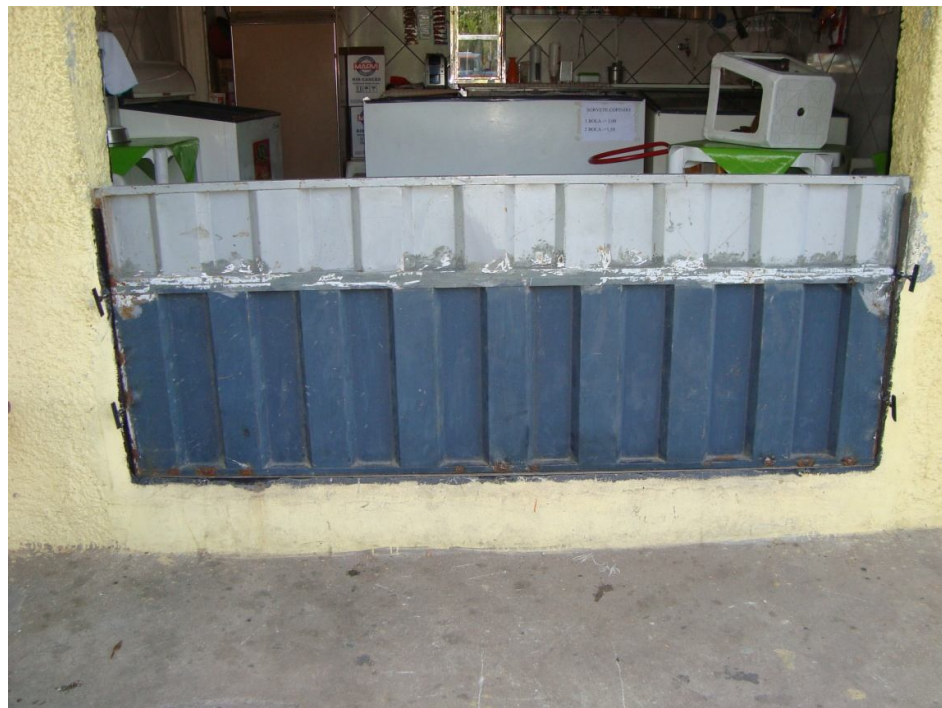
Fotografia 46 – Colocação de comporta metálica
