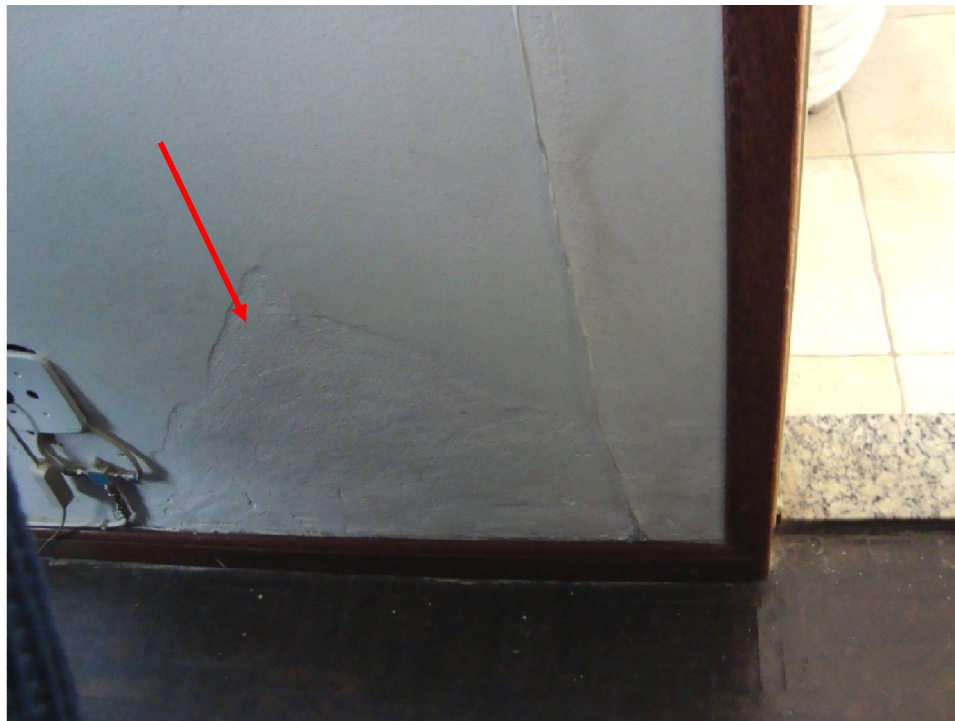
Fotografia 4 – Reconstituição do revestimento argamassado das paredes com posterior execução de pintura
