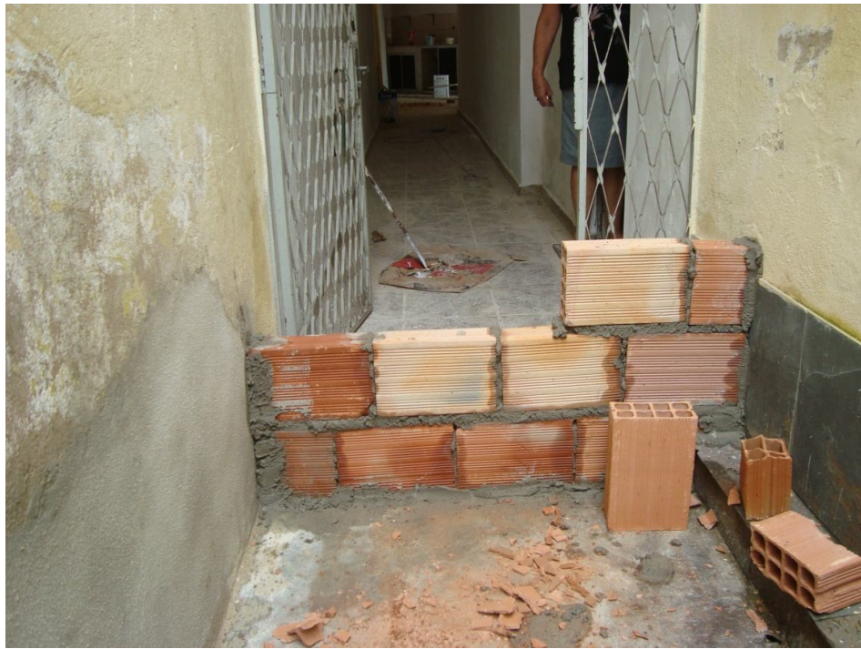
Fotografia 30 – Execução de barreiras de proteção
