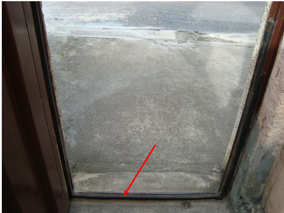
Fotografia 58 – Colocação de borracha de vedação no portão de entrada
