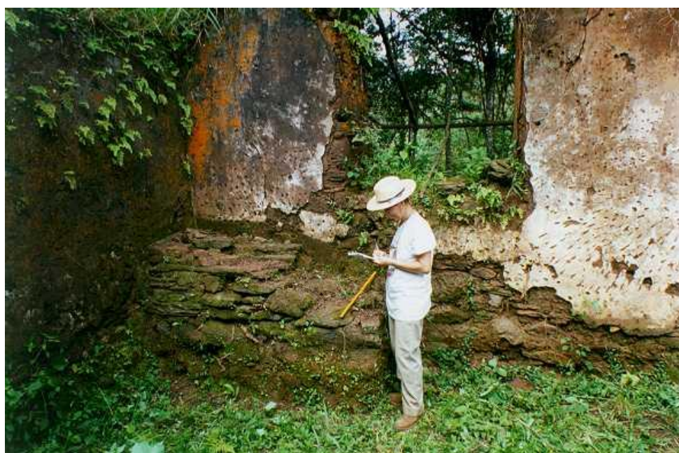
FIGURA 38 - anexo da "Casa do Portão", lado leste
