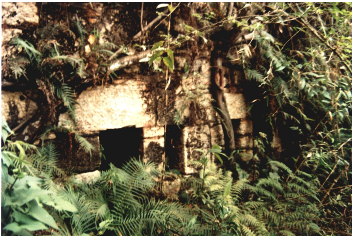
FIGURA 46 - Mina do Pari nos arredores de Santa Bárbara, 2001
