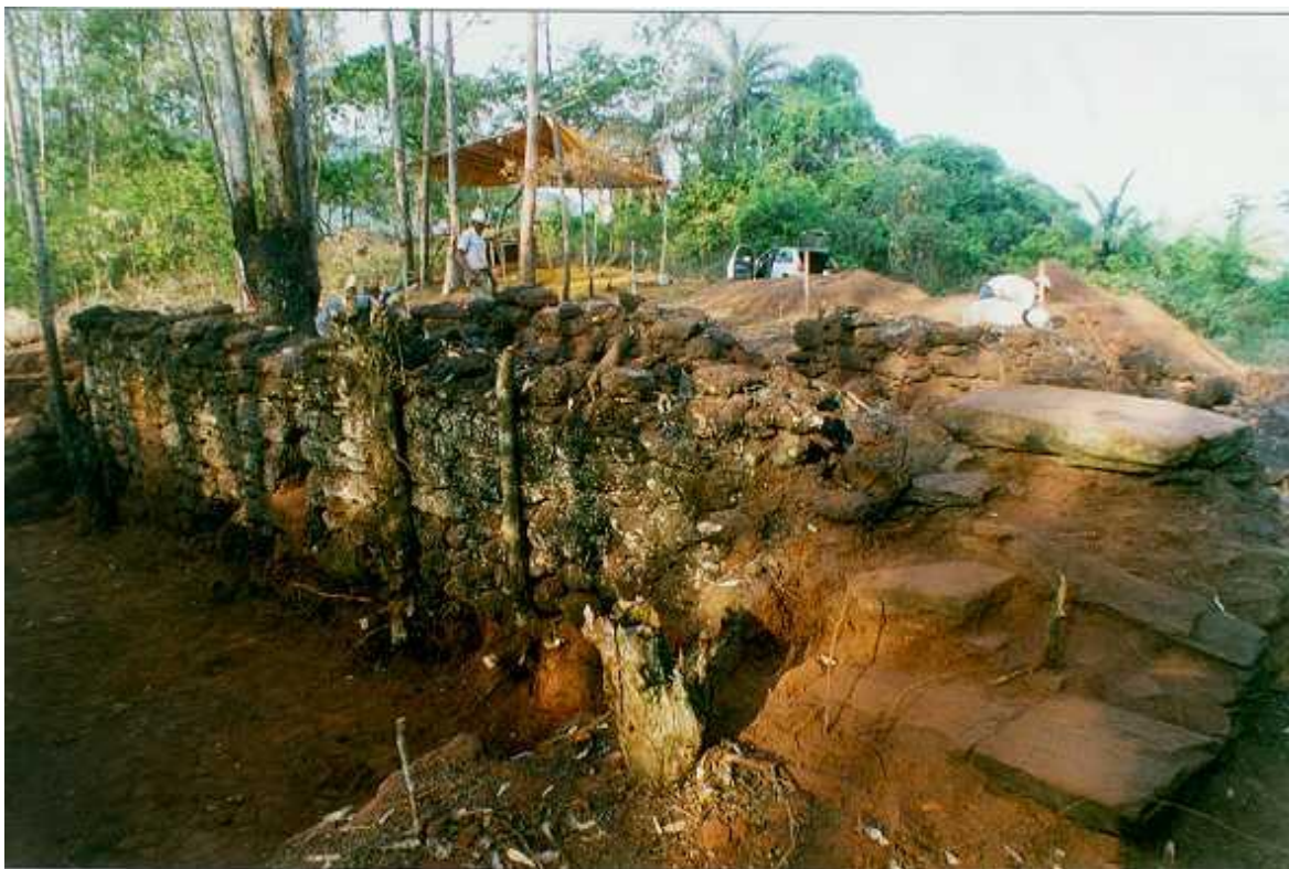
FIGURA 34 - "Casa do Cemitério" (no canto inferior direito está a escada de acesso e, na parte central da parede, o orifício de ventilação que interligava as duas porções do porão
