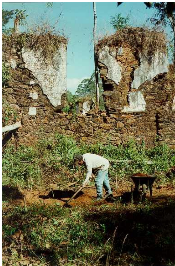
FIGURA 18 - Sondagem no pátio do Hospital vendo-se o vão da porta do corredor leste sem qualquer evidência de escada externa
