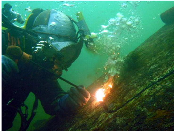
Figura 2.1 - Soldagem subaquática molhada
