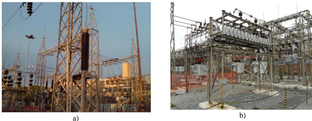
Figura 3.9 – Imagens da subestação Adelaide, a) para-raios, b) banco de capacitores série.
