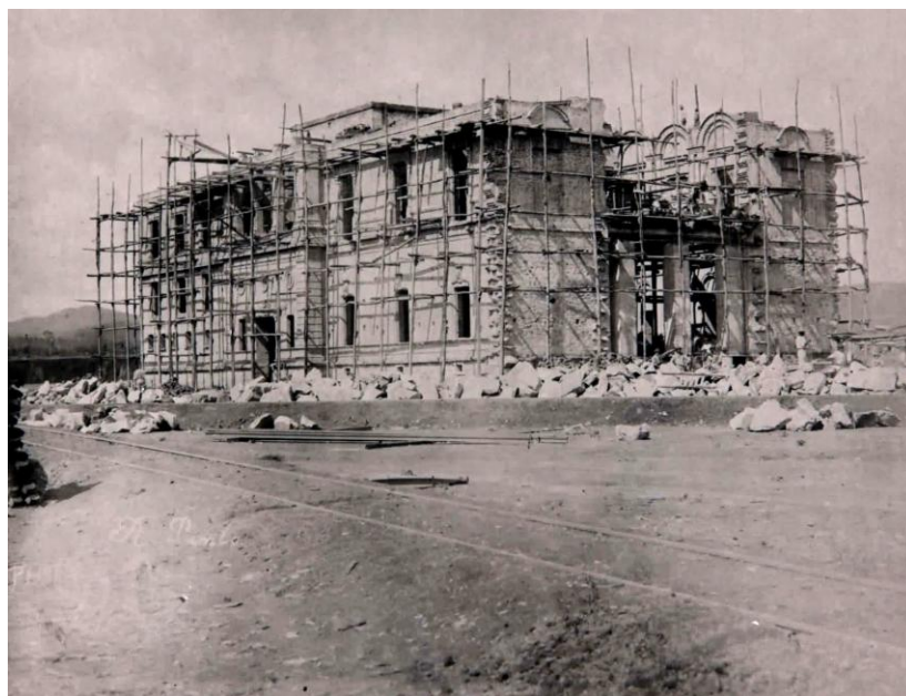
Construção do Palácio da Liberdade. 94
