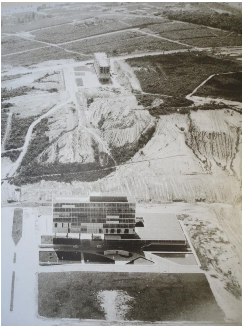
Construção do prédio da Reitoria da UFMG, 1963. 155
