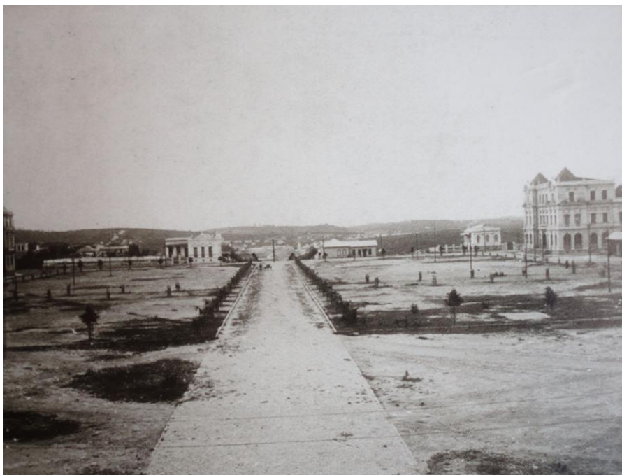
Praça da Liberdade em construção em 1897. Coleção: Adriano A. C. de Mendonça. 95
