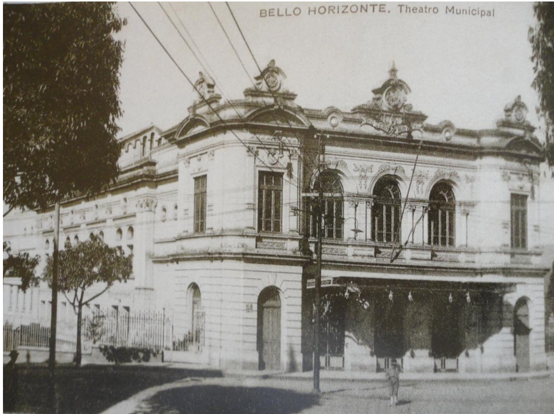
Foto da fachada do Teatro Municipal de Belo Horizonte, situado na Rua Goiás, esquina de Rua Bahia, onde, mais tarde, se instalou o Cinema Metr pole – sem data. 193
