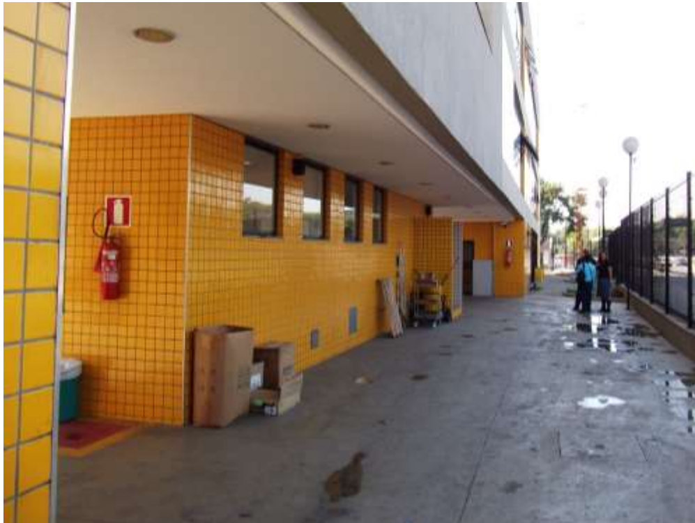
FIGS 11a, 11b, 11c e 11d– Almoarifado - sequência de fotos referentes ao espaços do Almoarifado, local por onde passam todas as ambulâncias do Samu para reposição de material e higienização. Verifica-se o cuidado com que são organizados, nomeados e higienizados, quando necessário. O espaço de higienização das ambulâncias, quando estas são lavadas, é bastante amplo e planejado conforme necessidades deste trabalho.
