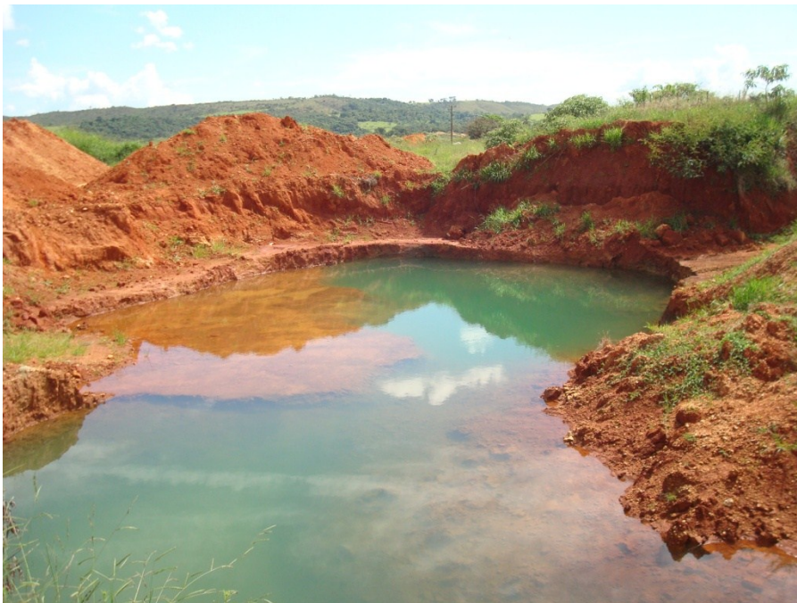
Figura 7.3: Trincheira para amostragem de bulk-sample executada pela GAR Mineração Ltda. para testes de viabilidade do Kimberlito Vargem utilizada para amostragem no trabalho (Ponto 1).
