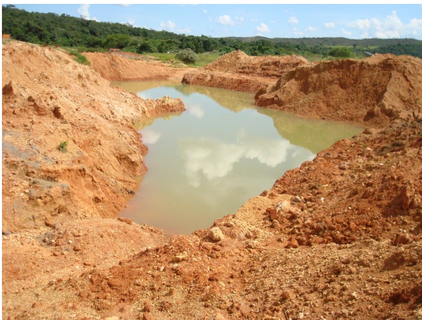
Figura 7.4: Trincheira para amostragem de bulk-sample executada pela GAR Mineração Ltda. para testes de viabilidade do Kimberlito Vargem utilizada para amostragem no trabalho (Ponto 2).
