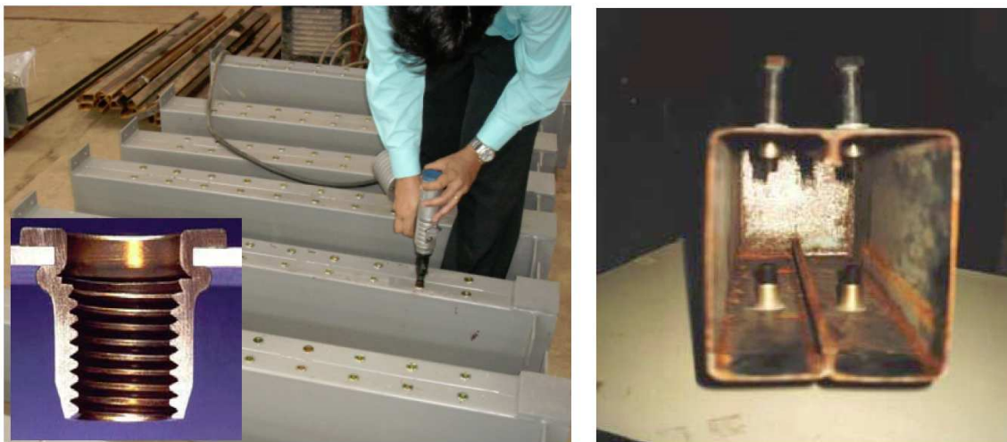
Figura 2.21. Conector com rebite com rosca interna e parafuso sextavado (Oliveira, 2001).
