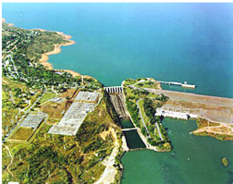
Figura 2.2 – Foto da Usina Hidrelétrica de Três Marias (Fonte: Banco de Dados - Cemig)
