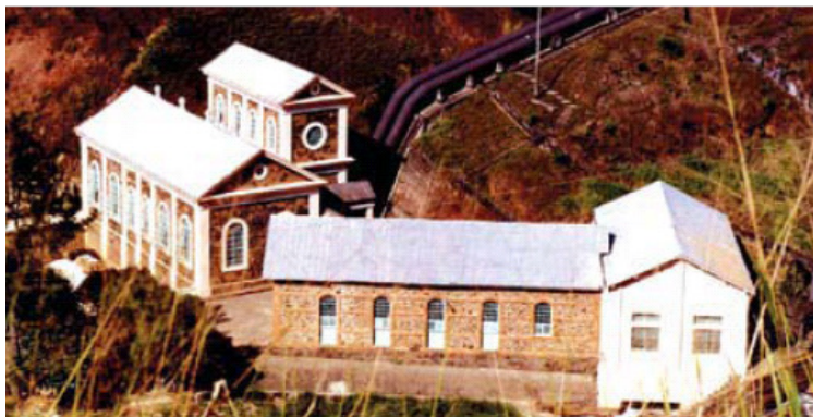
Figura 2.1 – Foto da Usina Hidrelétrica de Marmelos Zero (Fonte: Banco de Dados - Cemig)
