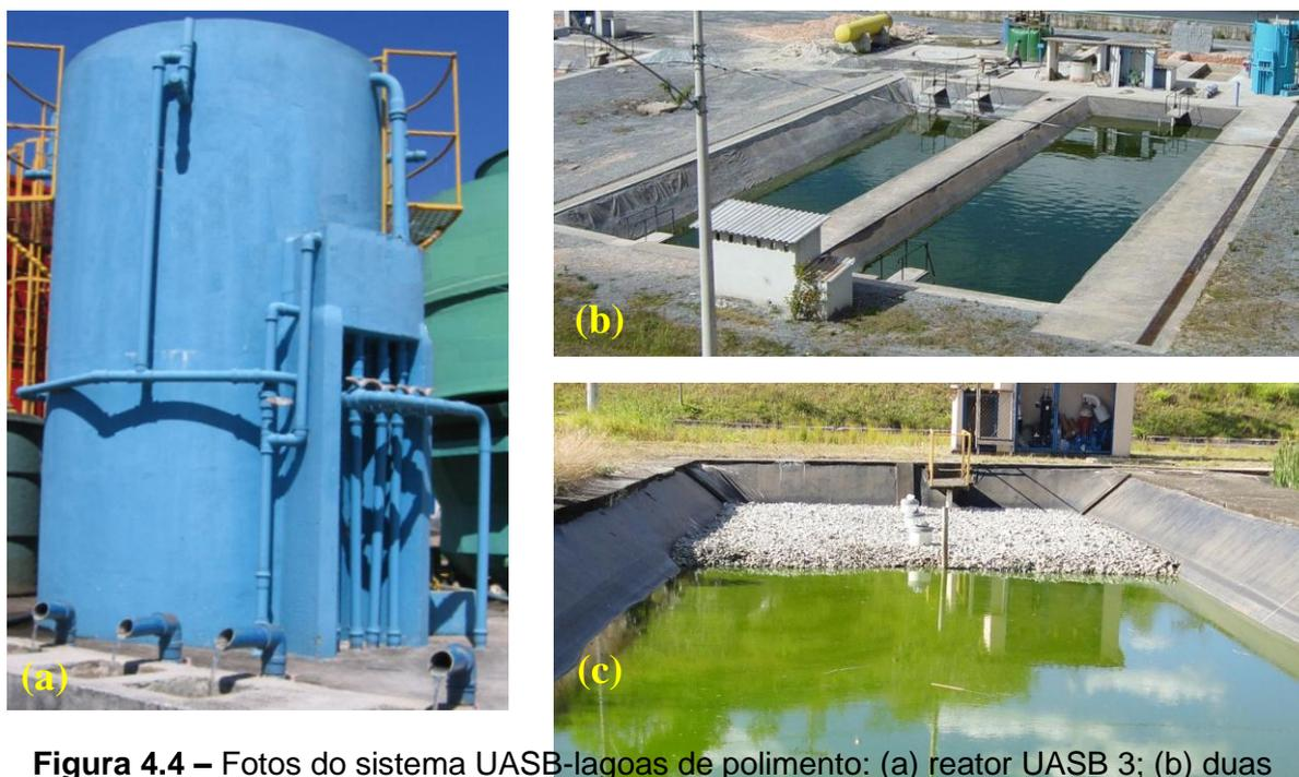
**Figura 4.4** – Fotos do sistema UASB-lagoas de polimento: (a) reator UASB 3; (b) duas primeiras lagoas de polimento; (c) filtro grosseiro de pedra locado no final da terceira lagoa
