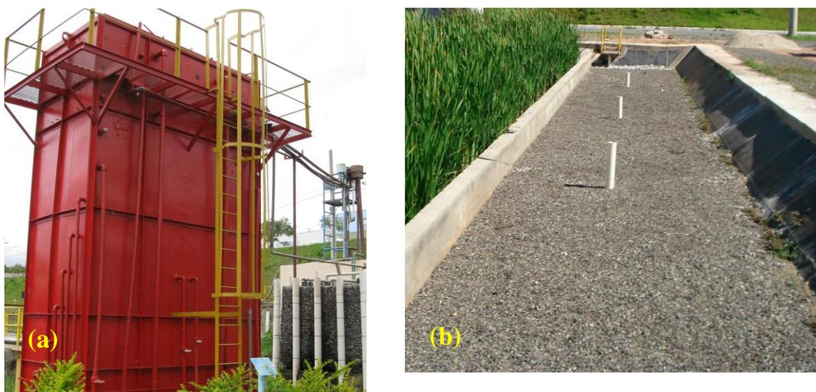
**Figura 4.2** – Fotos do sistema UASB-*wetland* construída não plantada: (a) reator UASB 1; (b) *wetland* construída não plantada de fluxo sub-superficial horizontal
