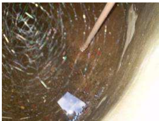
Figura 5.18 (q) – Água apresentando cor e turbidez, baixo nível da água e sujeiras no fundo e sobre a água.
