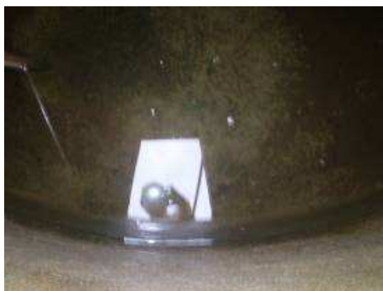
Figura 5.18 (bb) – Água com cor e turbidez elevadas, nível da água baixo e sujeira no fundo.
