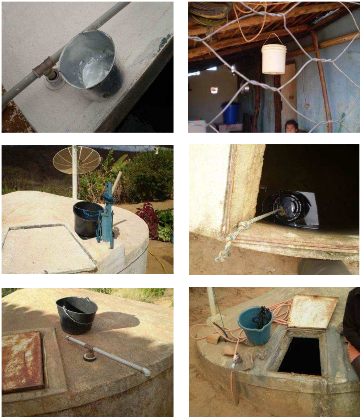
Figura 5.12 – Baldes utilizados para retirar água da cisterna.
