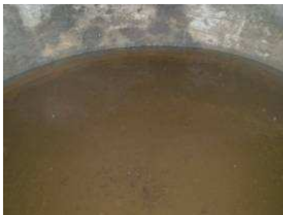
Figura 5.18 (r) – Água com cor e turbidez elevadas, baixo nível da água e sujeira no fundo.
