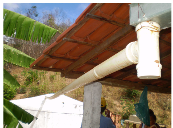
(f) Tê instalado invertido com Cap
