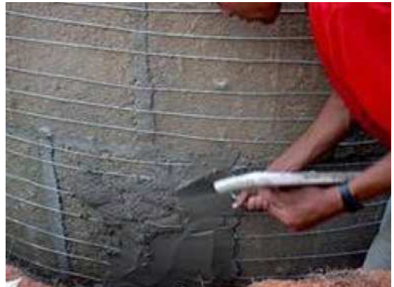
Figura 5.8 – Após os fios de arame enrolados faz-se o reboco externo.
