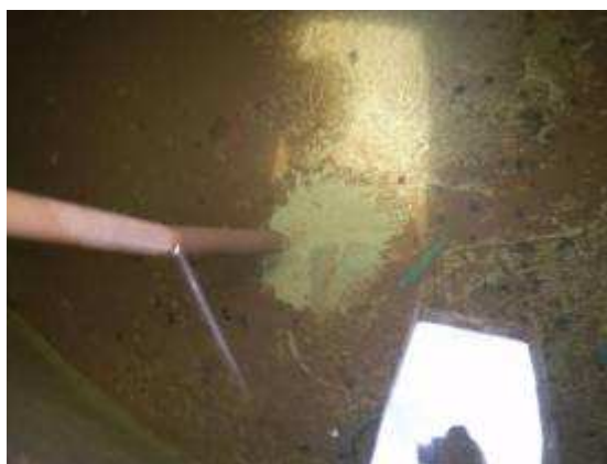
Figura 5.18 (v) – Água apresentando cor e turbidez elevadas, baixo nível da água e sujeira no fundo.
