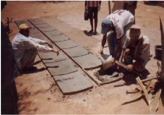
Figura 5.3 – Execução das placas em formas sobre o terreno.
