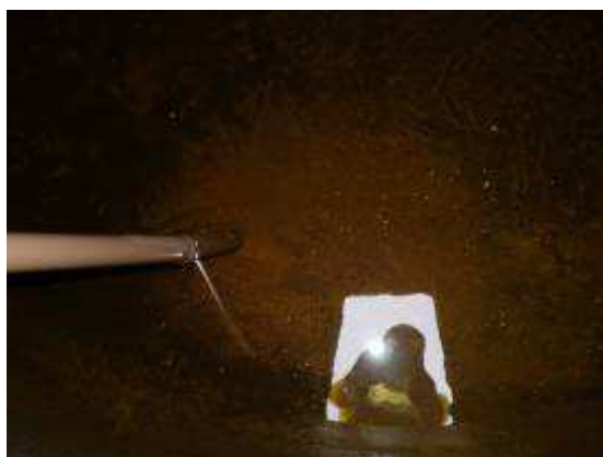
Figura 5.18 (n) – Água com cor e turbidez elevadas e baixo nível da água.
