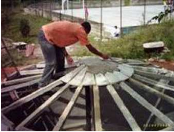
Figura 5.9 – Execução da cobertura da cisterna com placas e caibros de cimento.
