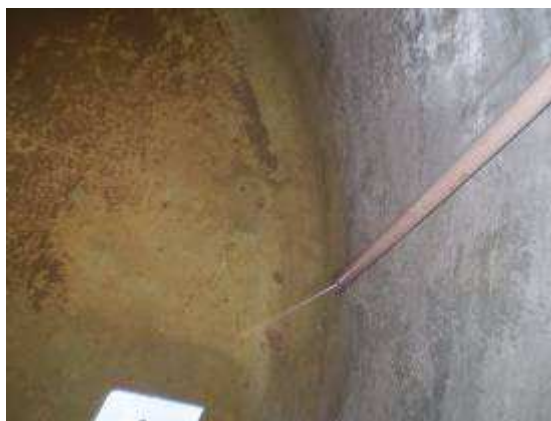
Figura 5.18 (u) – Água apresentando cor e turbidez elevadas, baixo nível da água e sujeira do fundo.
