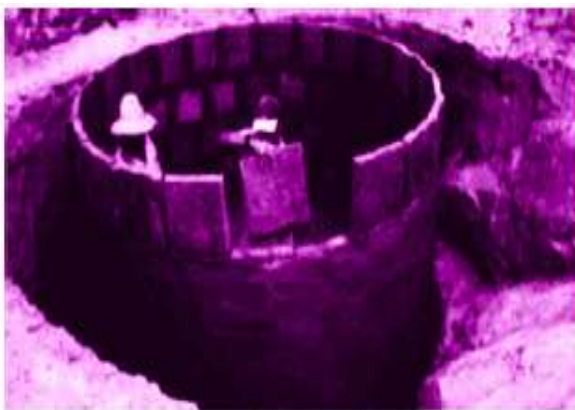
Figura 5.7 – Assentando as camadas de placas.
