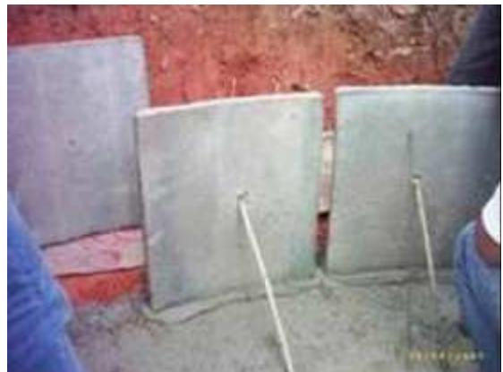
Figura 5.6 – Escoramento das placas com varas.
