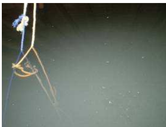
Figura 5.18 (z) – Água com cor e turbidez elevadas, nível da água alto e alguma sujeira sobrenadante.
