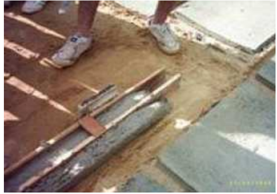
Figura 5.4 – Execução dos caibros de cimento.
