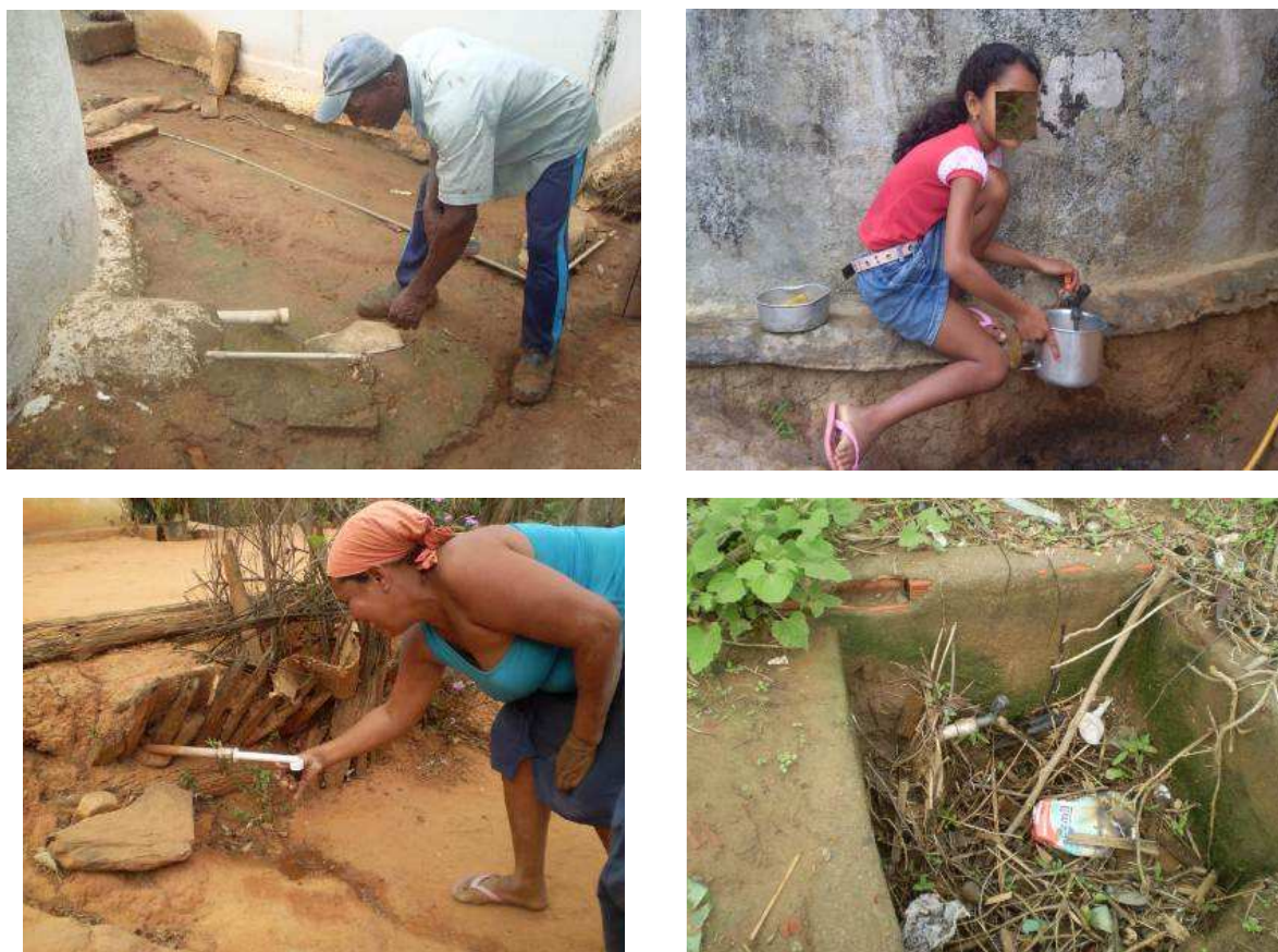
Figura 5.14 – Retirada da água usando tubulação com registro.
