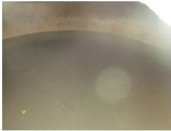
Figura 5.18 (i) – Água com cor e turbidez significativas e altura baixa do nível da água.
