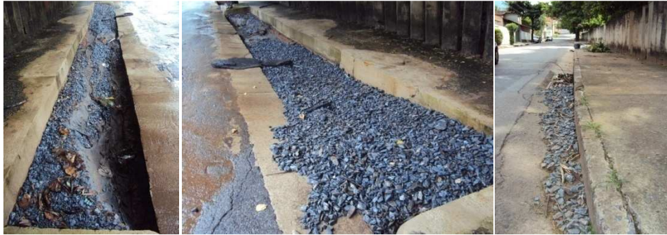
Figura 32 – Retirada de material de preenchimento - Sítio 4
