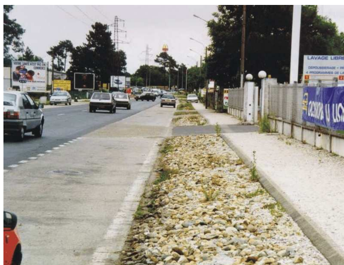
Figura 5 –Trincheira de infiltração (Fonte Baptista et al. 2005)
