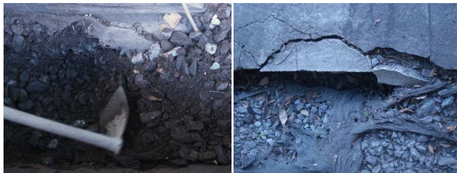
Figura 33 – Aporte de sedimentos e comprometimento da estrutura - Sítio 4
