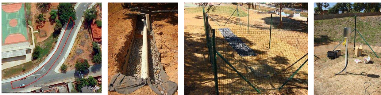
Figura 34 – Sítio 2 – Parque Nossa Senhora da Piedade (da esquerda para a direita: área de drenagem delimitada pela linha vermelha, tubo distribuição de vazão, trincheira de infiltração, pluviógrafo)
