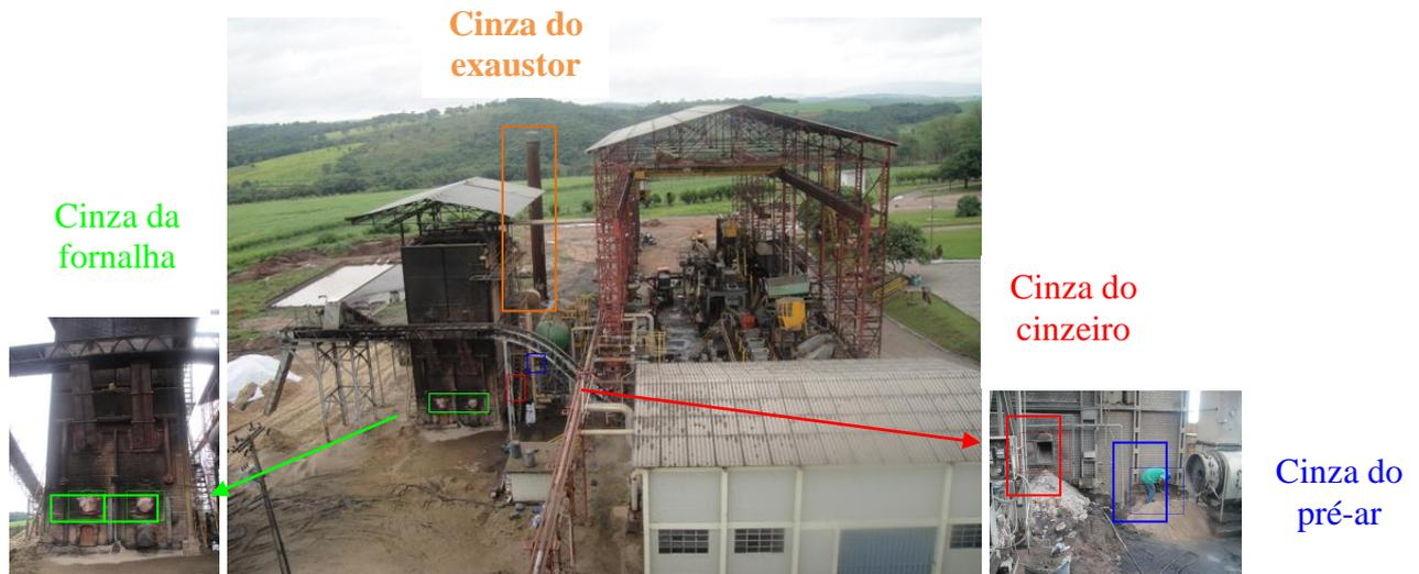
Figura 3.2 — Visão geral da Usina Alpha, mostrando a localização de onde são retiradas as diferentes cinzas: fornalha, cinzeiro, pré-ar e exaustor.
