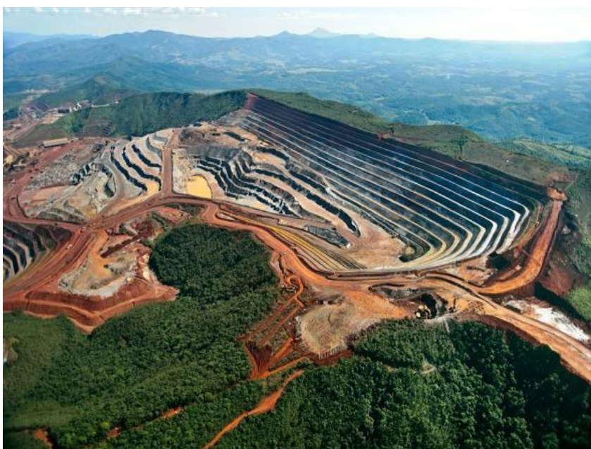
Figura 3.14. Foto aérea da mina de Brucutu localizada na Serra do Machado (Arquivo particular do autor, 2006).
