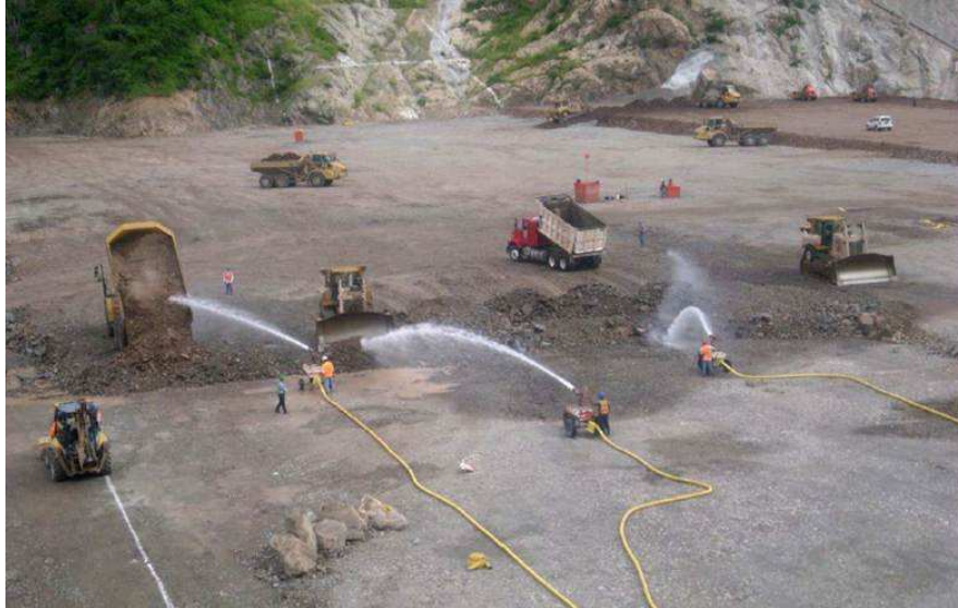
Figura 2.5: Lançamento, espalhamento e molhagem do enrocamento (Watzko, 2007).
