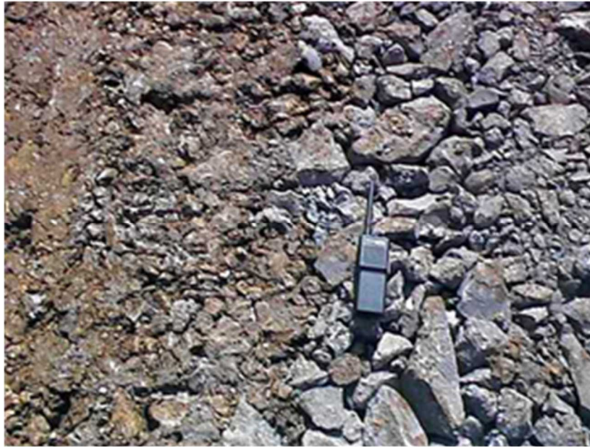
Figura 2.2: Enrocamento Fino, Waztko (2007).
