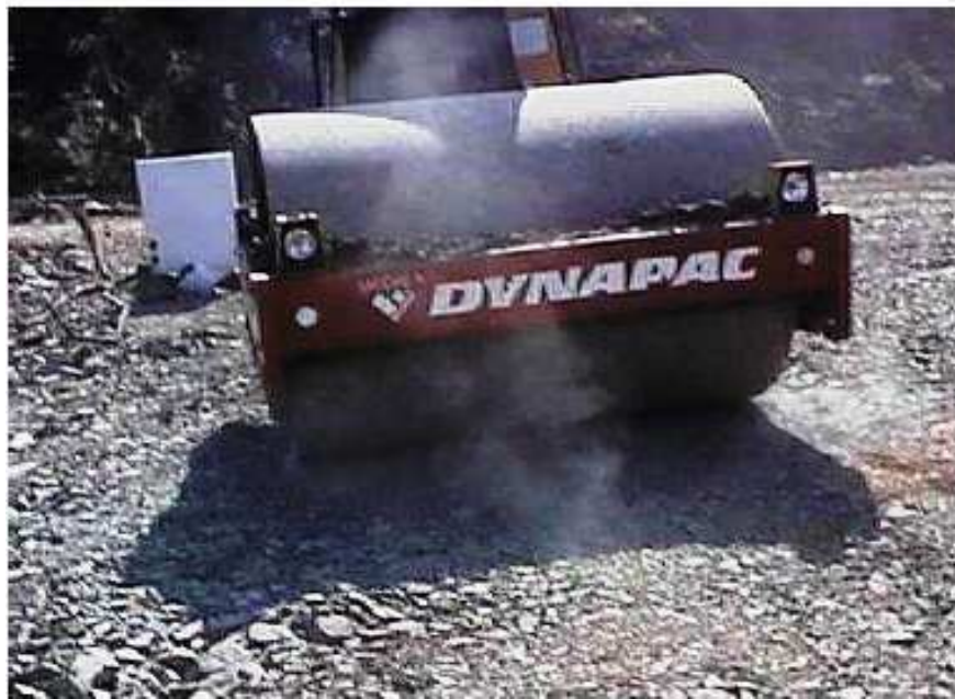
Figura 2.6: Molhagem e compactação. (Watzko, 2007)
