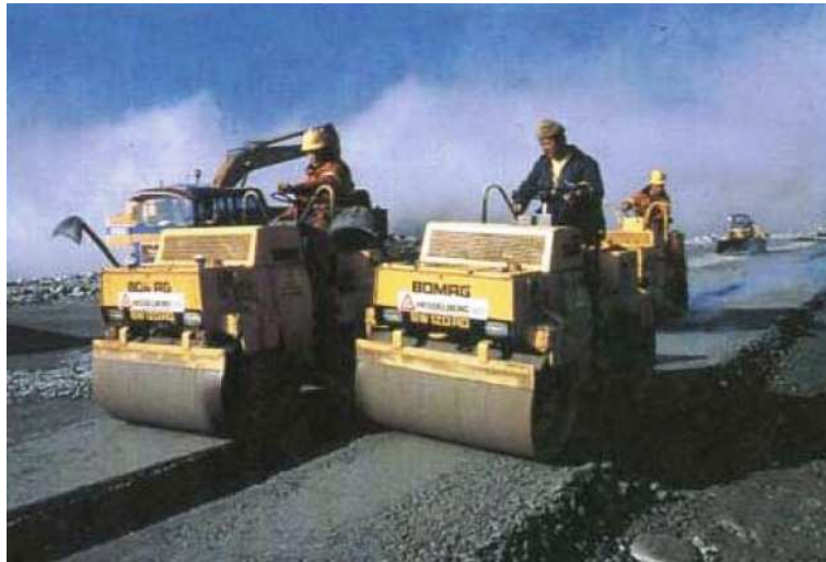
Figura 2.15: Compactação do núcleo e transições (Falcão, 2007).
