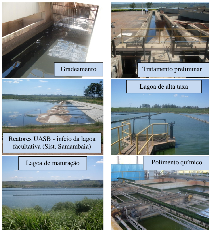
Figura 5.36 – Estruturas da ETE Samambaia – Visita técnica.
