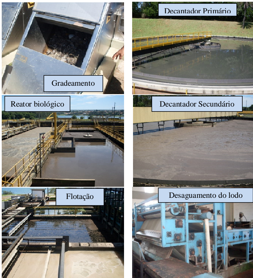
Figura 5.2 – Estruturas da ETE Brasília Norte – Visita técnica.
