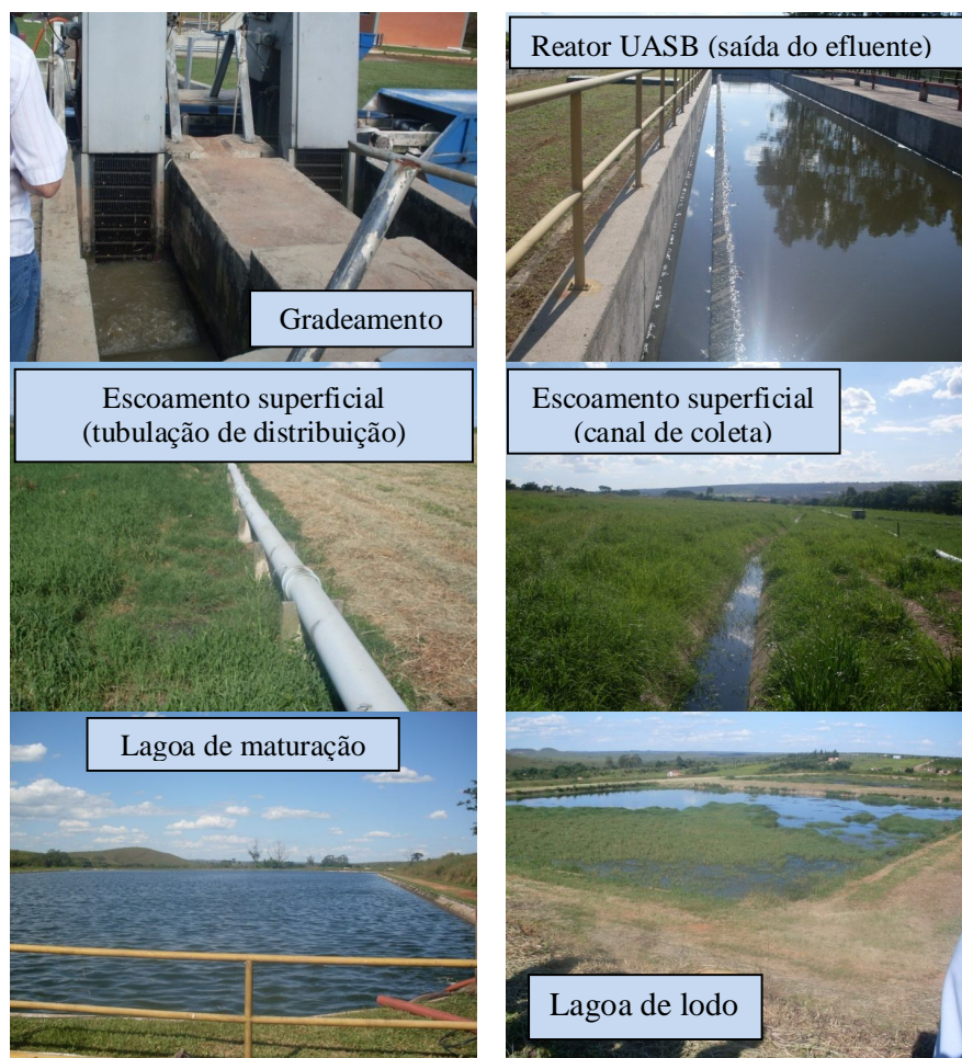
Figura 5.67 – Estruturas da ETE São Sebastião – Visita técnica.
