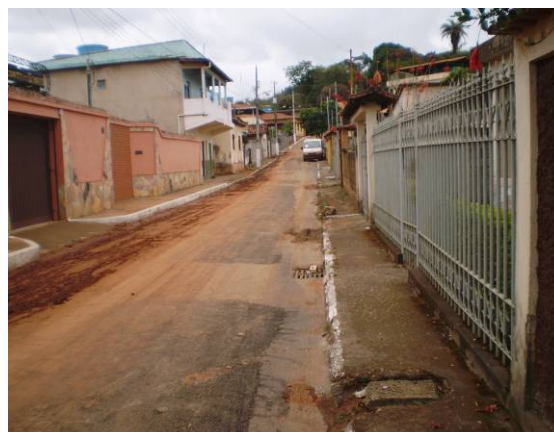
Figura 5.5 – Rua com pavimentação do distrito. Data: 12/10.
