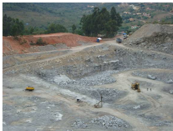
Figura 3.16 – Detalhe dos equipamentos de perfuração de rocha utilizados na lavra.
