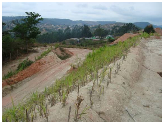
Figura 3.19 – Vista dos taludes superiores a partir do topo da pilha.
