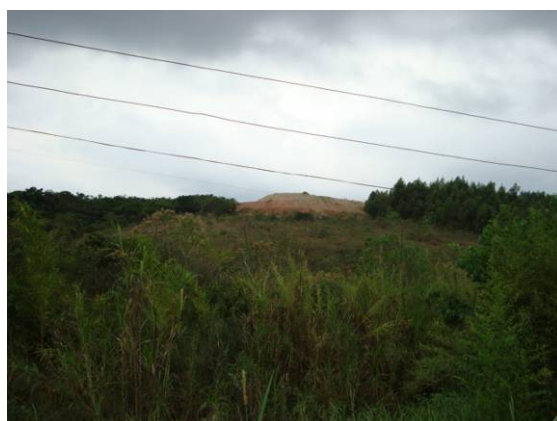
Figura 3.21 – Vista da pilha a partir da base.
