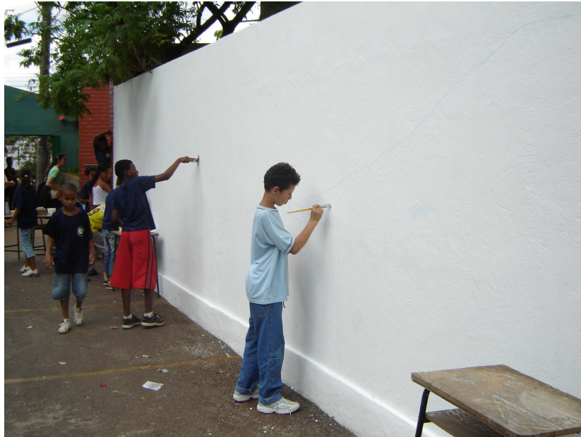
Preparação do muro da escola para receber o painel
