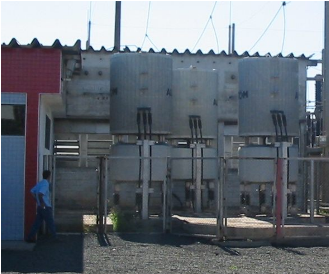
Fig. 36 - Reatores Séries Sem Dispositivo de Comutação de 'Taps'
