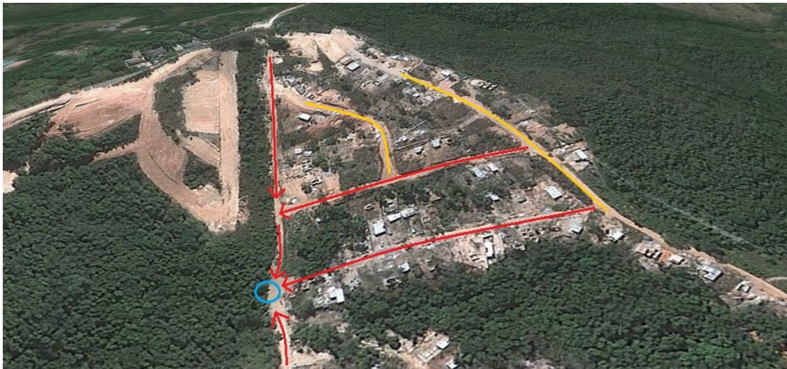
Figura 18. Bairro Roma: sentido de caminhamento das águas a partir das vias até o fundo de vale
