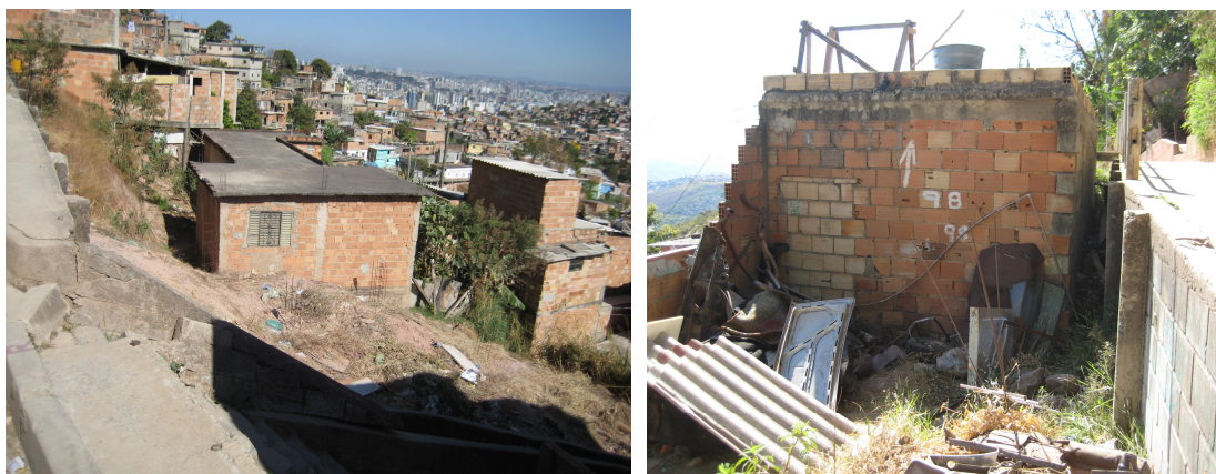
Figura 38. Vila Nossa Senhora de Fátima: via a montante com arrimo
