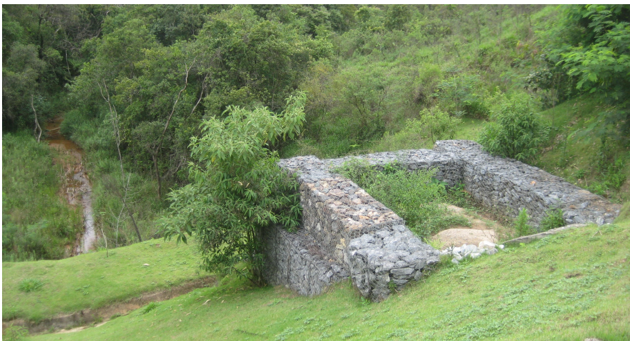
Figura 59. Caixa drenante de gabião (condomínio Vale dos Cristais em Nova Lima)
