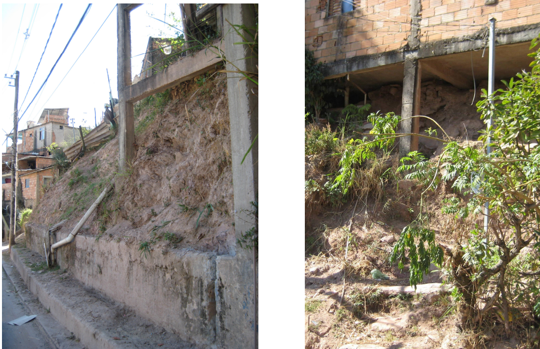
Figura 37. Vila Nossa Senhora de Fátima: casas com estrutura de palafita em concreto armado
