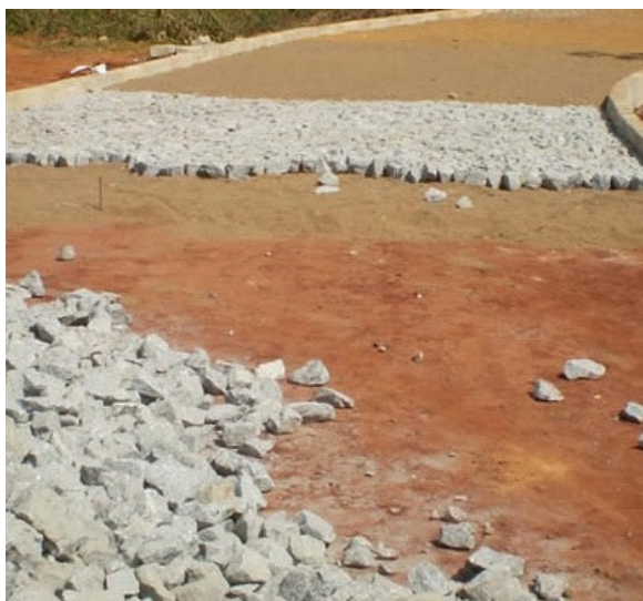
Figura 54. Calçamento poliédrico e piso intertravado (condomínio Vale dos Cristais, Nova Lima)
