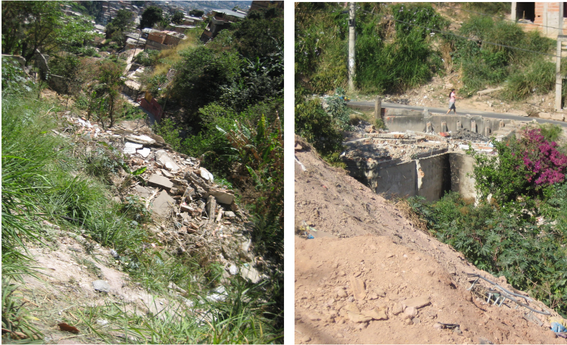
Figura 42. Vila Nossa Senhora de Fátima: Entulho de demolição deixado no local
