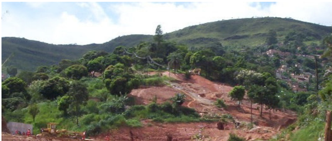
Figura 32. Preparo de encosta do Aglomerado da Serra para implantação de prédios
