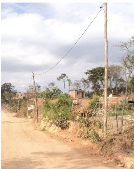
Figura 23. Bairro Roma: rede improvisada de distribuição de energia elétrica
