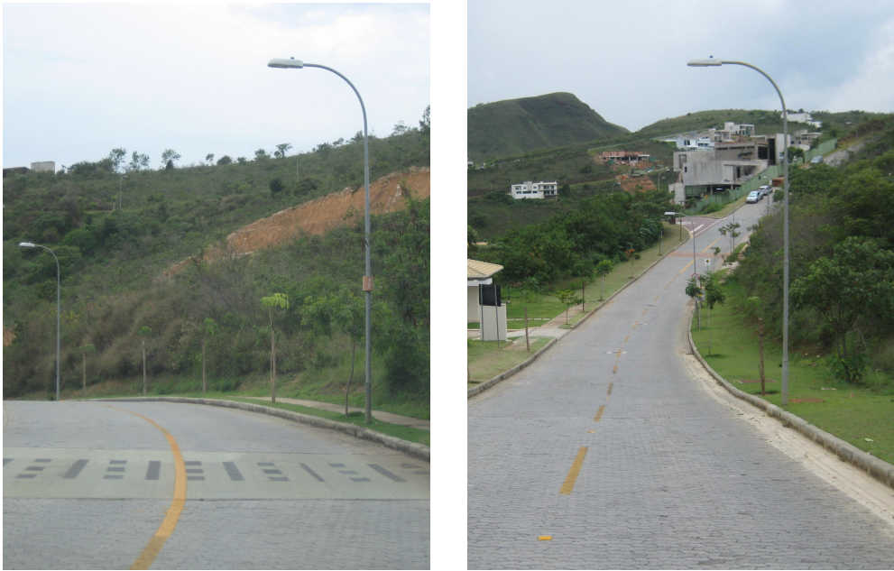
Figura 60. Distribuição subterrânea (condomínio Vale dos Cristais em Nova Lima)
