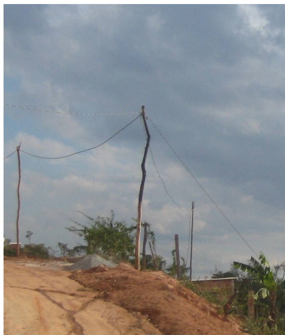
Figura 23. Bairro Roma: rede improvisada de distribuição de energia elétrica
