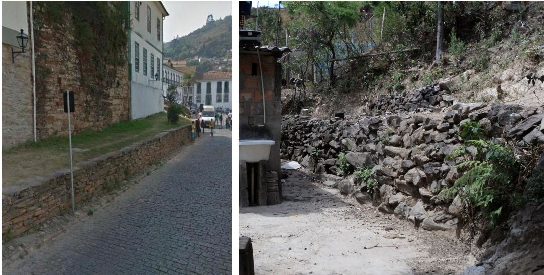
Figura 53. Muretas de pé de talude em Ouro Preto e no Aglomerado da Serra
