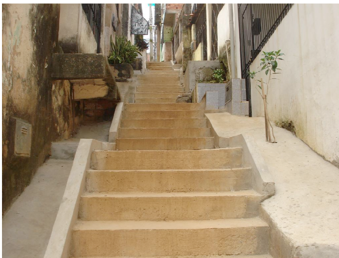
Figura 46. Substituição de ERD por escadaria convencional em Salvador
