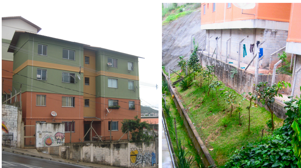
Figura 33. Agglomerado da Serra: prédios habitacionais implantados em platôs com arrimos
