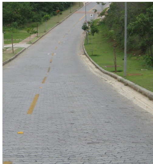
Figura 54. Calçamento poliédrico e piso intertravado (condomínio Vale dos Cristais, Nova Lima)
