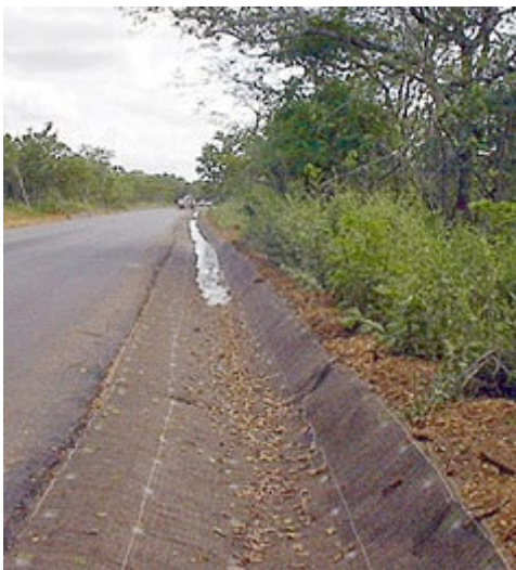
Figura 58. Canaleta com biomanta em rodovia Fonte: www.deflor.com.br
