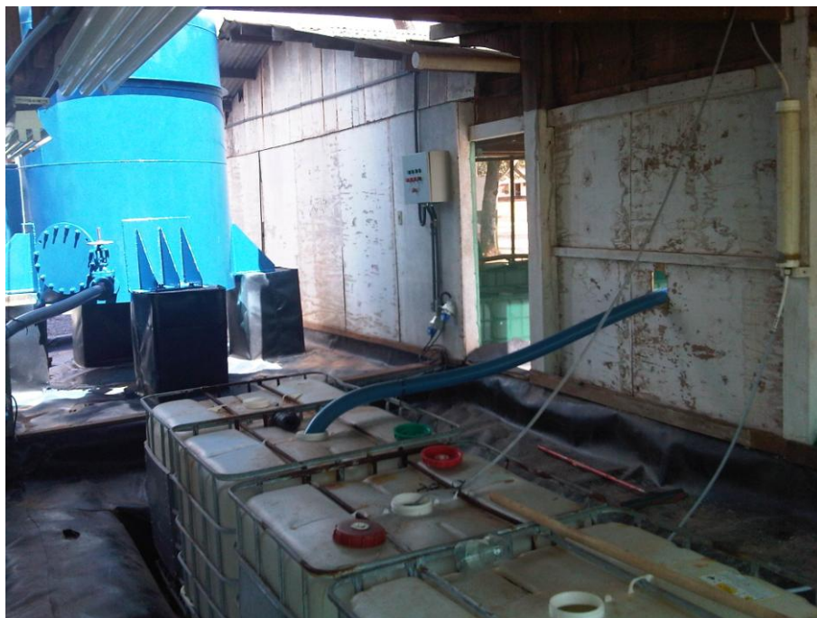
Figura 5.3 – Foto do sistema interno de dosagem e armazenamento das soluções rica e pobre.
