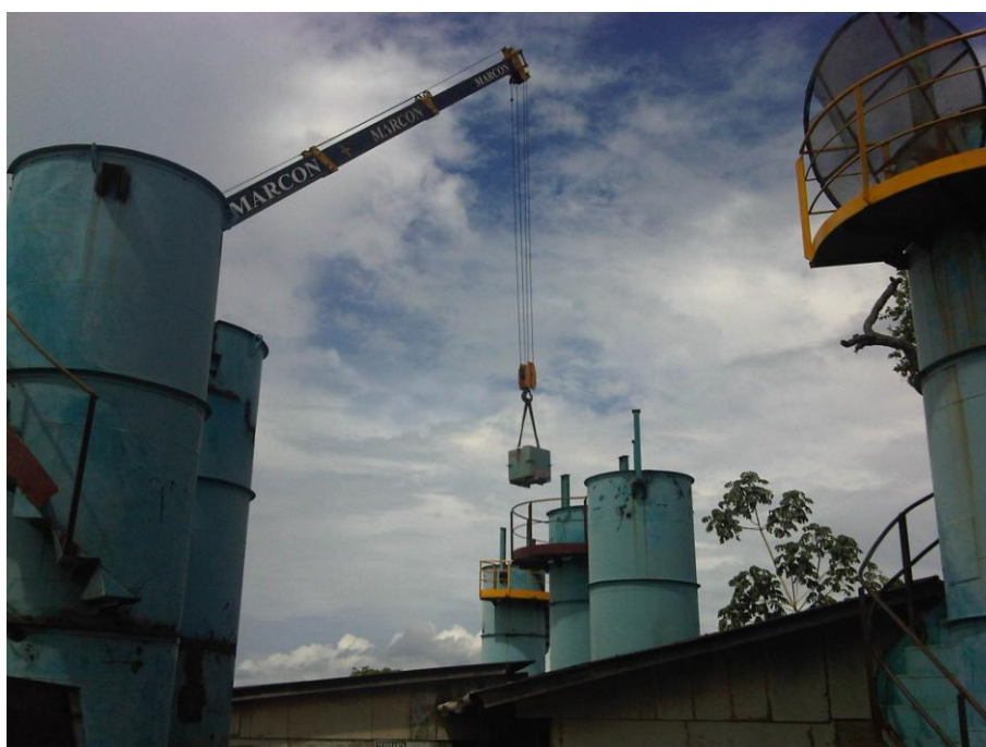
Figura 5.10 – Foto do enchimento da coluna gigante com o auxílio do guindaste.
