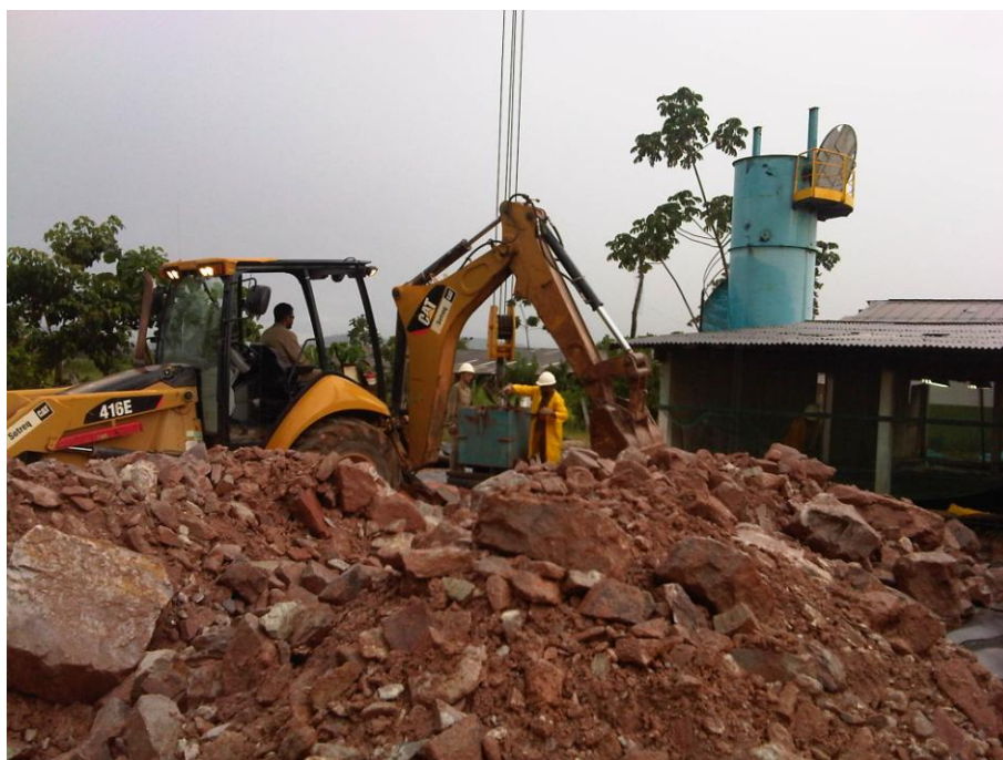
Figura 5.9 – Foto do enchimento da caçamba com o auxílio da retroscavadeira.
