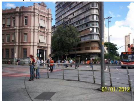
Figura 248 - O guarda-corpo provoca um deslocamento no eixo de caminhada do pedestre.
