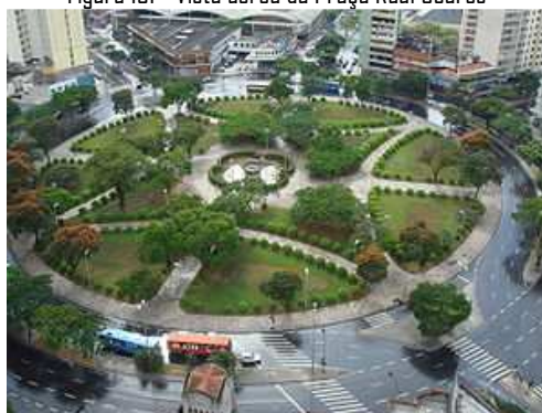
Figura 161 - Vista aérea da Praça Raul Soares
