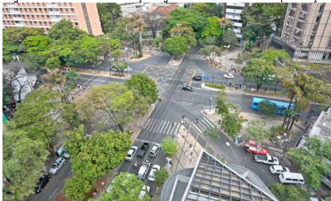
Figura 225 - Vista aérea da Praça Diogo Vasconcelos antes da requalificação.
