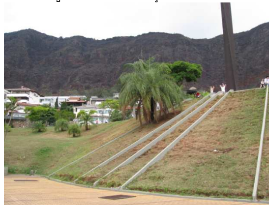
Figura 88 - Talude na Praça Israel Pinheiro.
