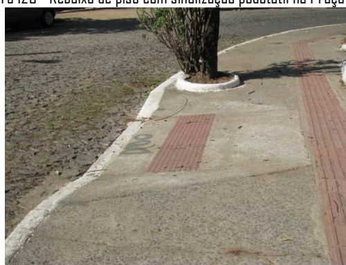
Figura 120 - Rebaixo de piso com sinalização podotátil na Praça Chuí.
