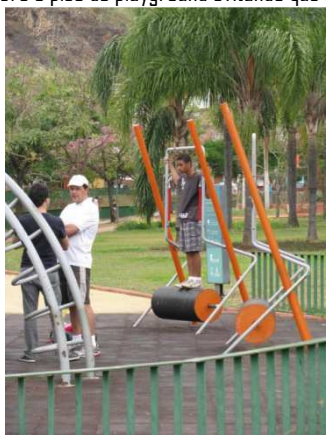
Figura 118 - O piso de raspas de pneu cobre o piso do playground evitando que as crianças se machuquem com a queda.
