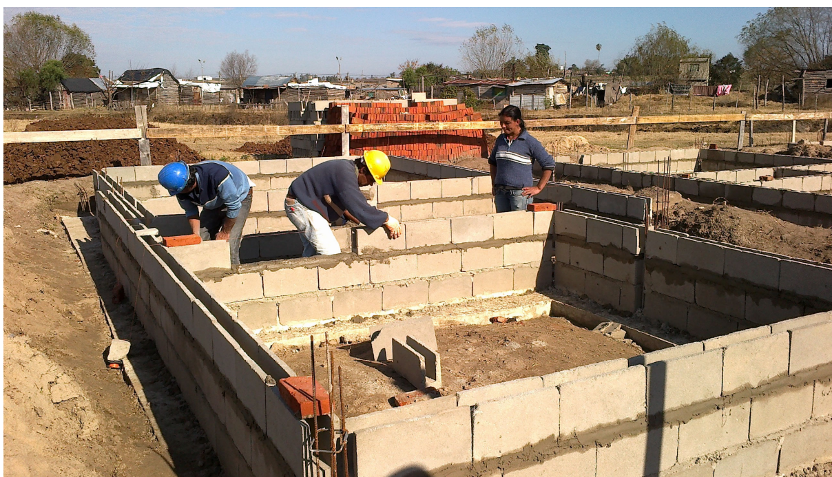
Fotografia 21 – Família de cooperados em autoconstrução no canteiro de obras do Projeto La Isla – Tacuarembó / Uruguai
