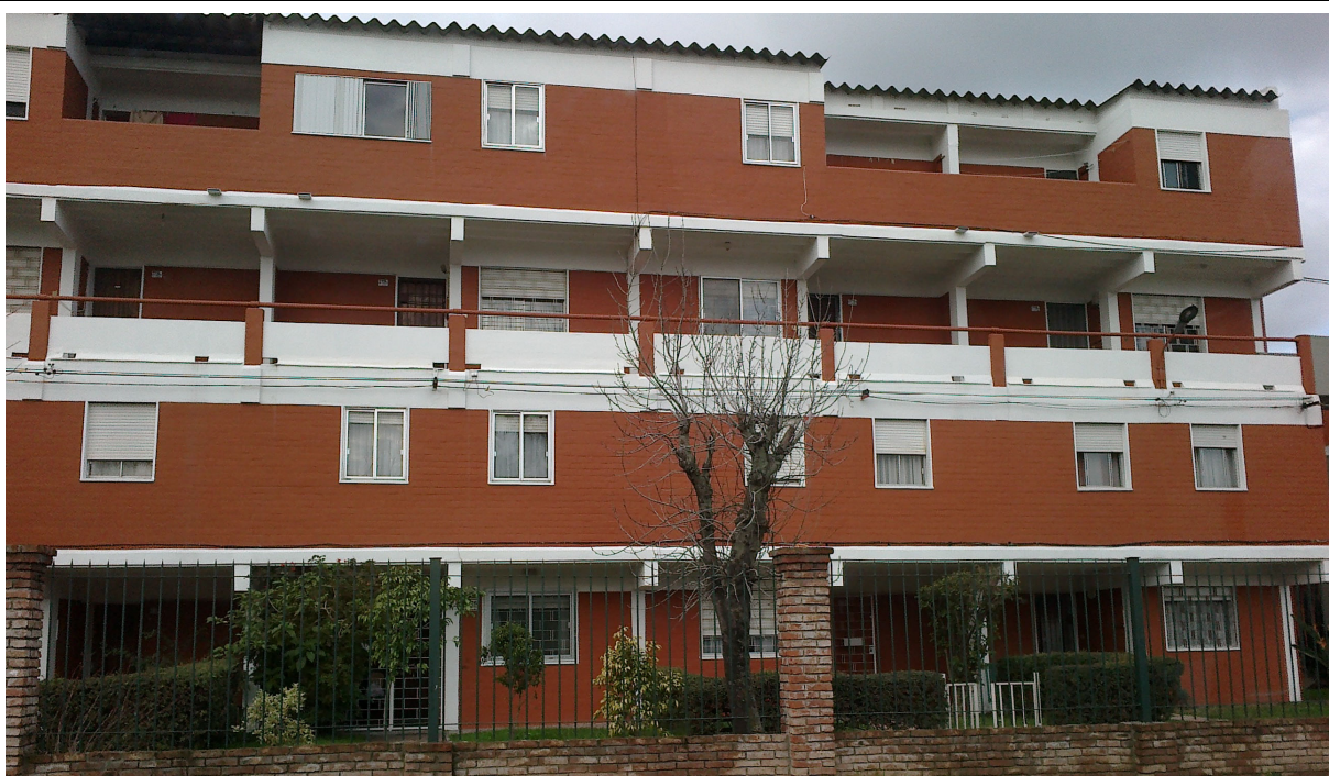
Fotografia 14 – Fachada. Modularização dos conjuntos de cooperativas pioneiras habitacionais de usuários por ayuda mutua – Montevideu / Uruguai
