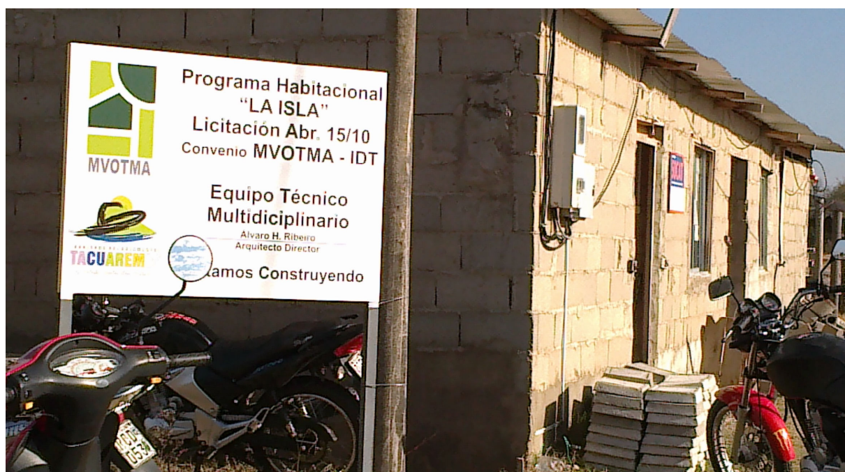
Fotografia 19 – Canteiro de obras de cooperativas de autoconstrução em um realojo (reassentamento). Programa Habitacional La Isla – Tacuarembó / Uruguai
