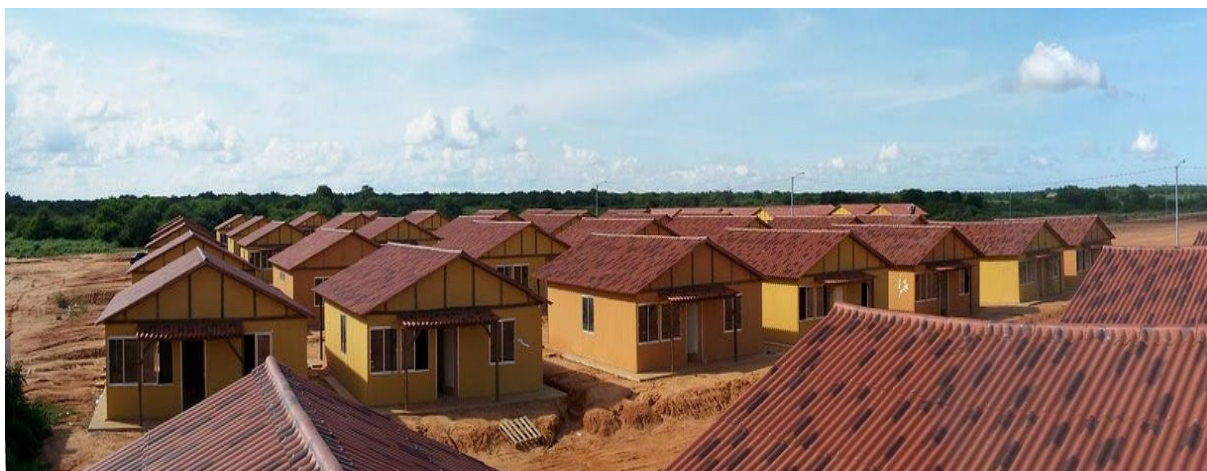
Fotografia 23 – Sistema internacional de arquitetura industrializada UMISSA / NOX, para o atendimento de interesse social. Canteiro de obras em Maracaibo / Venezuela
