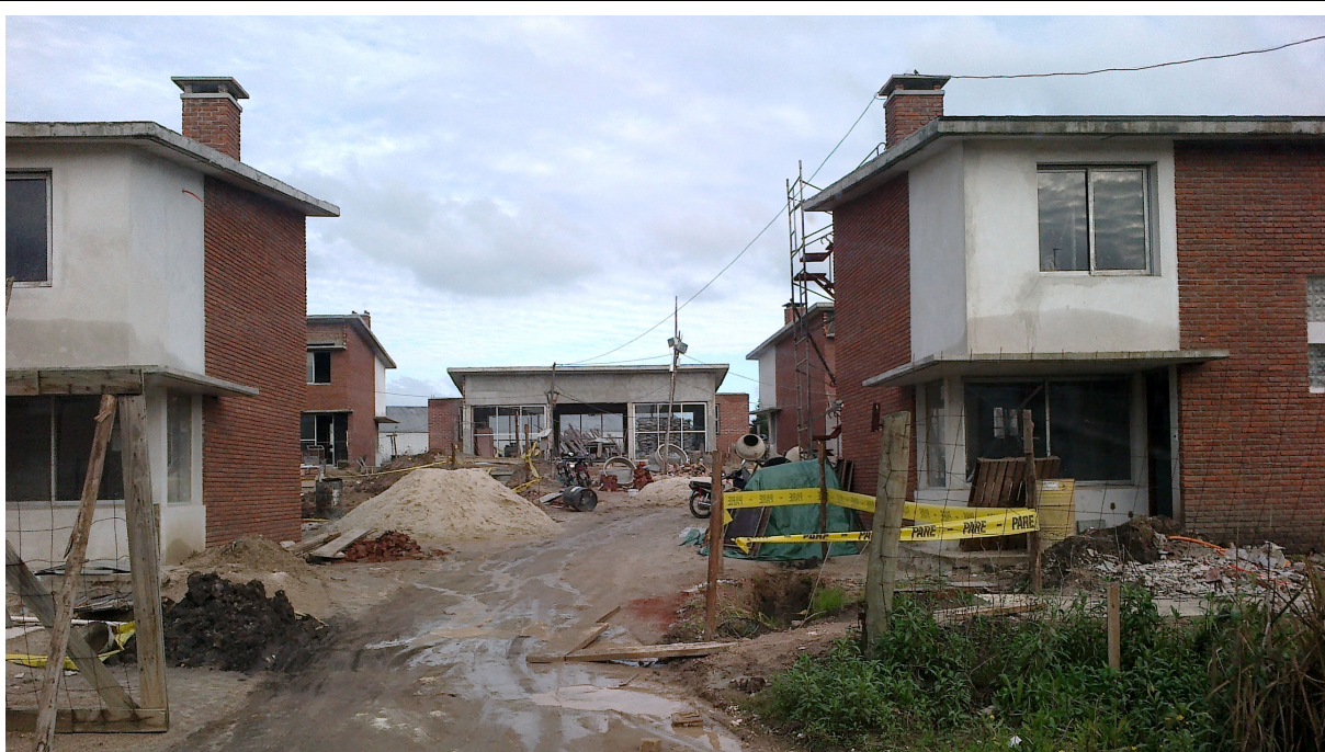
Fotografia 16 – Detalhe da modulação de casas. Canteiro de obras de cooperativas contemporâneas habitacionais de usuários por ayuda mutua – Montevidéu / Uruguai
