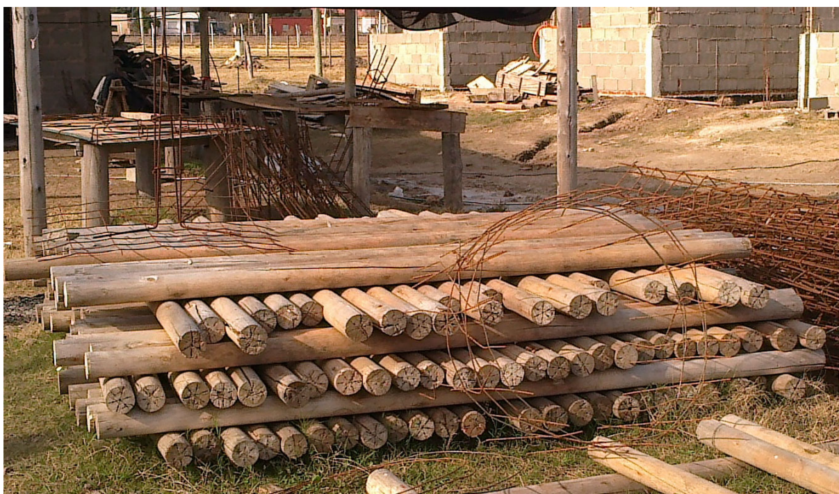
Fotografia 26 – Pilaretes de madeira em aplicação convencional nos canteiros de obras de construção civil – Tacuarembó / Uruguai
