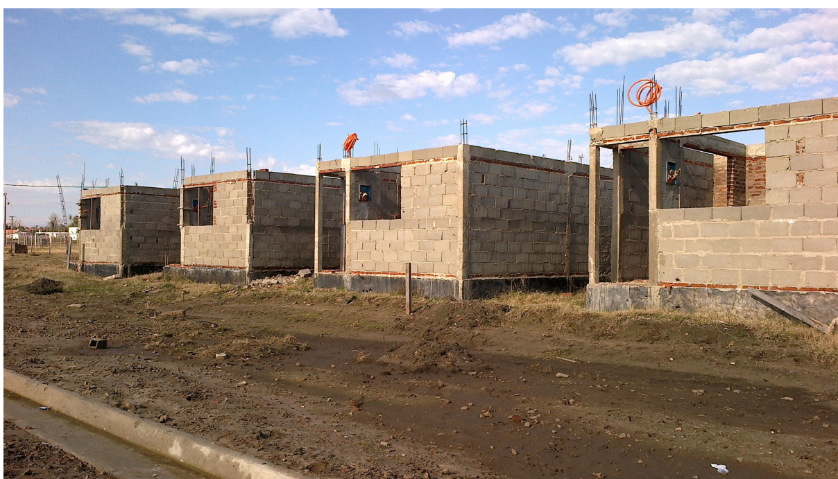
Fotografia 22 – Casas Modulares sendo erguidas por meio de cooperativas de autoconstrução. Canteiro de obras do Projeto La Isla – Tacuarembó / Uruguai
