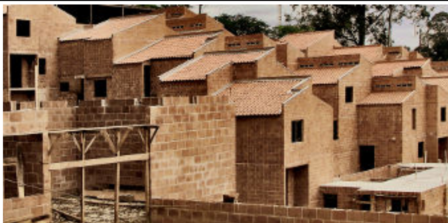
Fotografia 1 – Comuna Urbana Dom Helder Câmara: primeiro assentamento urbano do Movimento dos Trabalhadores Rurais Sem-Terra (MST). Financiamento: Prefeitura Municipal de Jandira, Ministério das Cidades e Caixa Econômica Federal. Jandira/SP.
